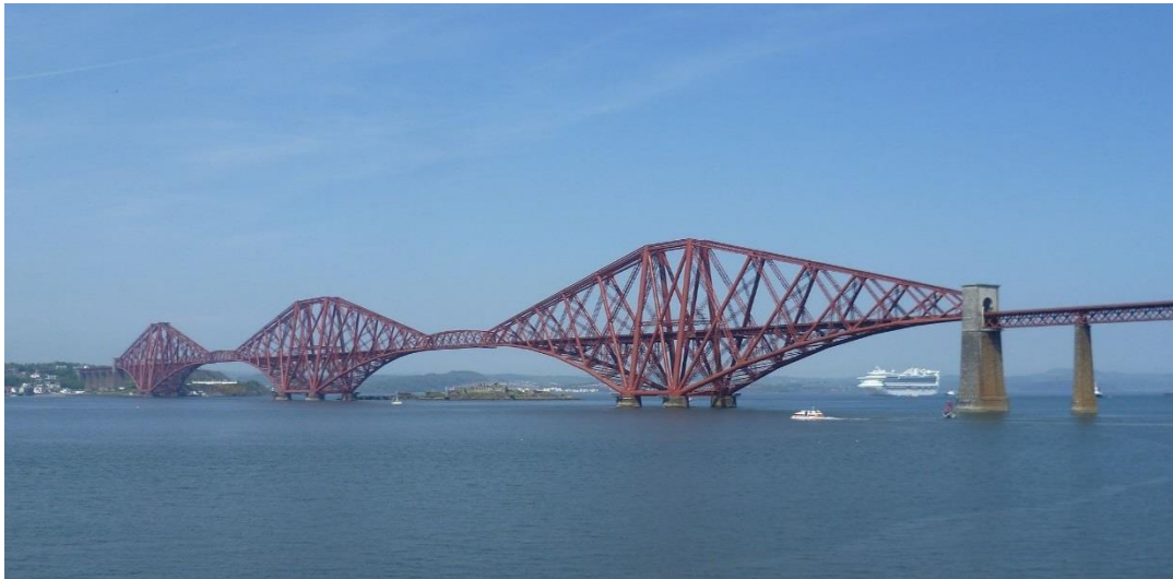
Εικόνα 1.11: Γέφυρα Φορθ Ρέιλ.
