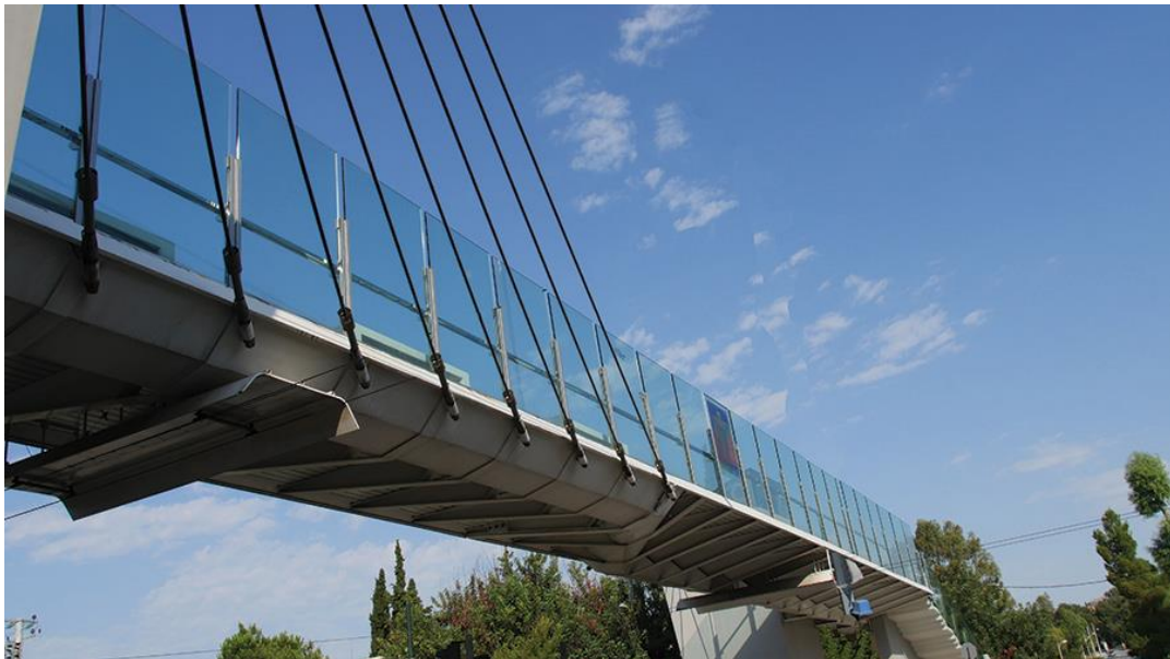
Εικόνα 1.17: Καλωδιωτή Πεζογέφυρα Κολλεγίου επί της Λ. Κηφισίας
