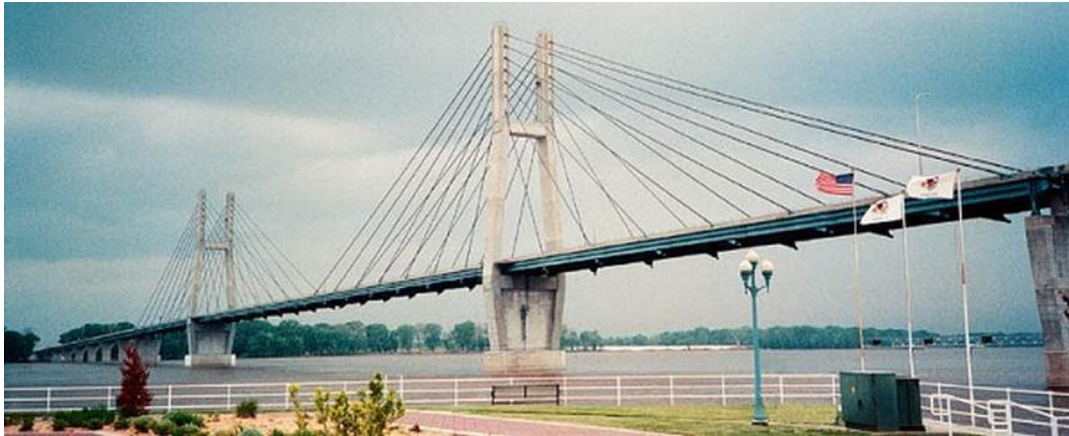
Εικόνα 3.1: Η καλωδιωτή γέφυρα Quincy Bayview στο Illinois της Αμερικής
