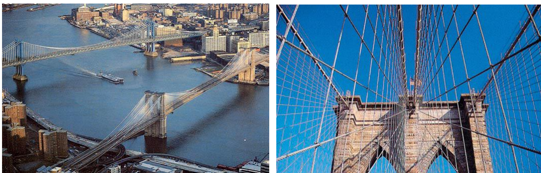
Εικόνα 1.28: Γέφυρα Brooklyn στην Αμερική, 1869
