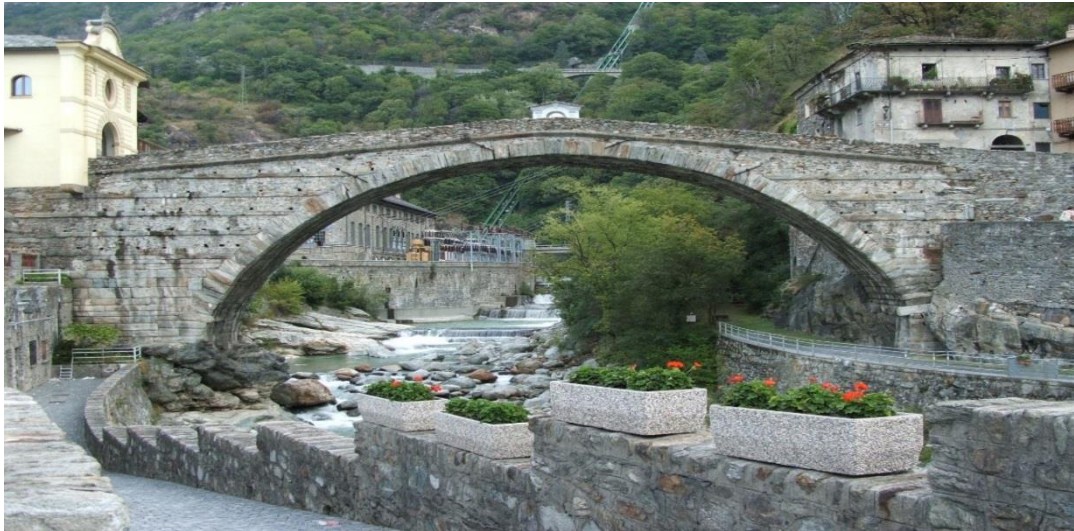
Εικόνα 1.3: Γέφυρα Σεν Μαρτίβ
