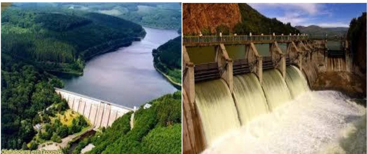
Σχήμα 1.1,1.2 Εικόνες φραγμάτων σε ΥΗΕ
