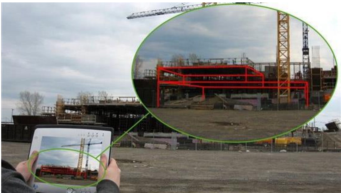
Εικ.5.6: Χρήση της κινητής τηλεφωνίας για παρακολούθηση της προόδου του έργου [πηγή: http://www.qualityinconstruction.com/use-of-tablets-for-site-inspections/ ]
