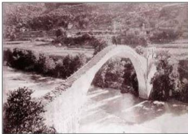
Εικ.2: Η γέφυρα στις αρχές του 20 ου αι. όπου διακρίνονται οι ατέλειες στο κατάστρωμα και η απουσία του στηθαίου. (Πηγή: Α. Τσουβάλης, από τη συλλογή φωτογραφιών του ιστότοπου «Πέτρα πέτρα η γέφυρα της Πλάκας»)
