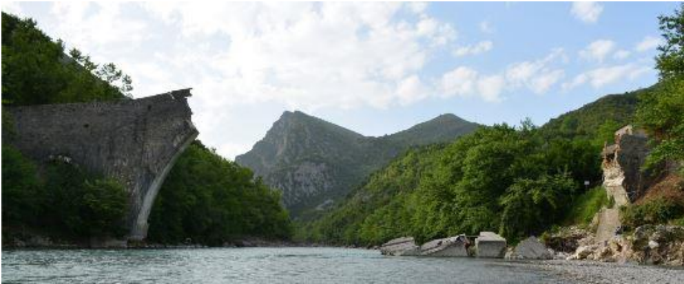
Εικ.45: Άποψη της γέφυρας από κατάντη (22/5/2015)
