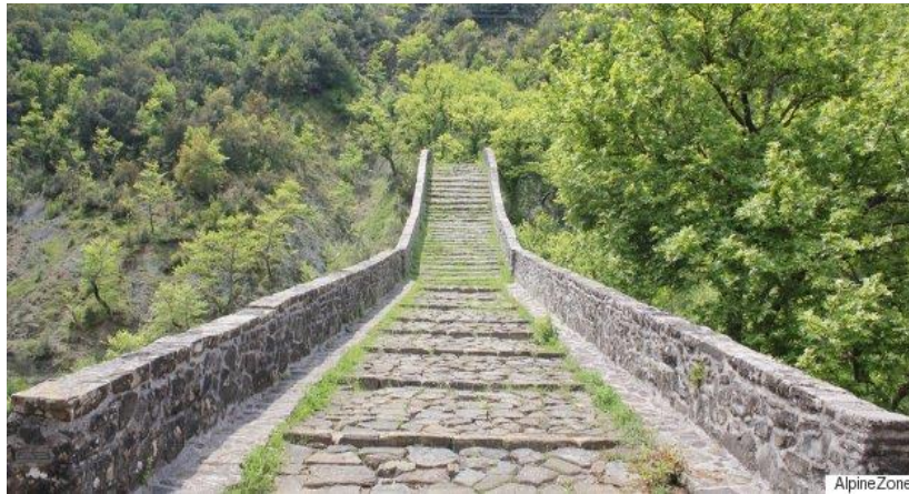
Εικ. 11: Όψη του καταστρώματος της γέφυρας και των στηθαίων ασφαλείας.
