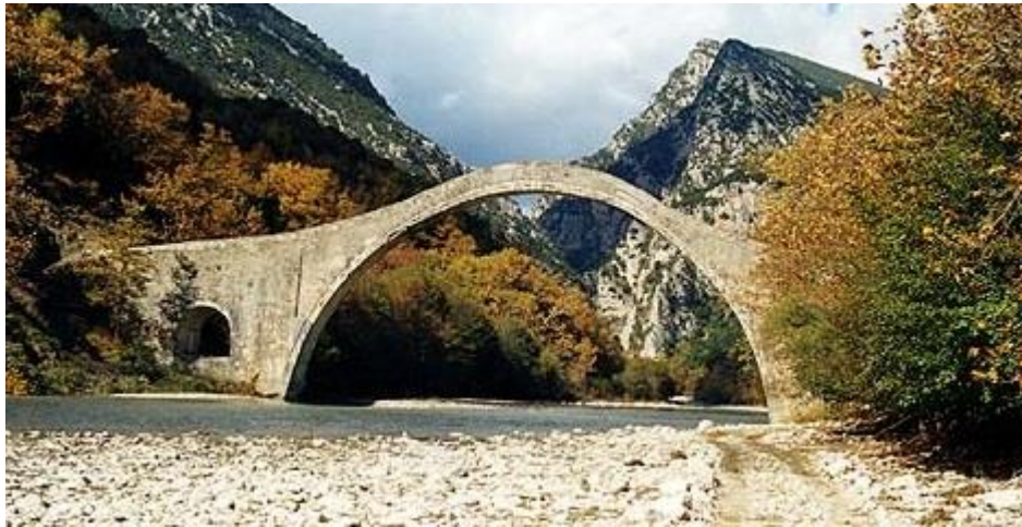
Εικ. 44: Όψη της γέφυρας από τα κατάντη.
