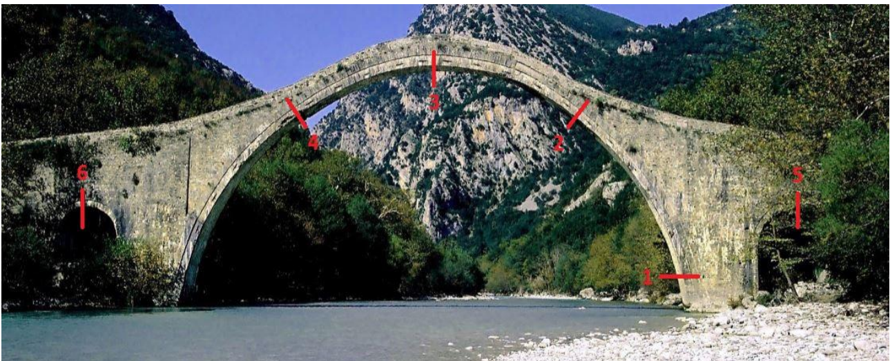
Εικ.71: Κατάντη όψη της γέφυρας. Επισημαίνονται οι θέσεις ελέγχου υπέρβασης της εφελκυστικής αντοχής. Φωτογραφικό Αρχείο ΕΜΠ
