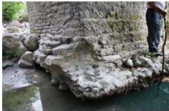
Εικ.21 : Άποψη του ανατολικού βάθρου από το ανάντη μέτωπο σε περίοδο χαμηλής στάθμης του Αράχθου.
