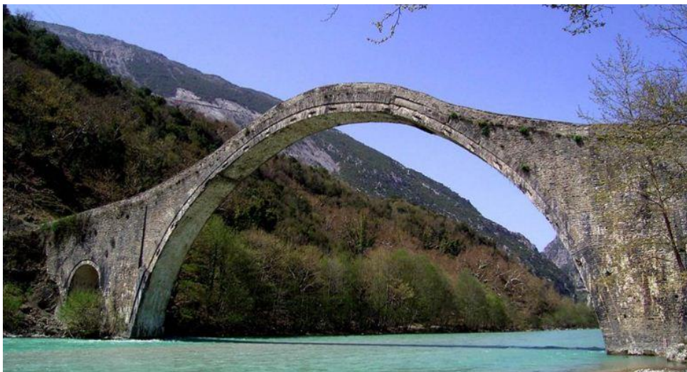
Εικ 31: Κατάντη όψη της γέφυρας.
