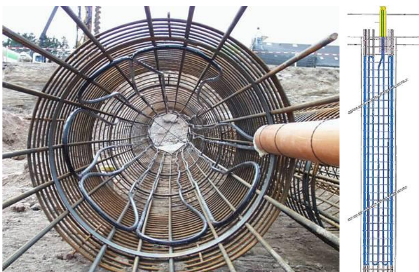
Εικόνα 21. Οι βρόχοι σωληνών και ο σπλισμός σε έγχυτο πάσσαλο -γεωεναλλάκτη. Φωτογραφία της διατομής και σχέδιο όψης καθ' ύψος (Widerin, 2009).
