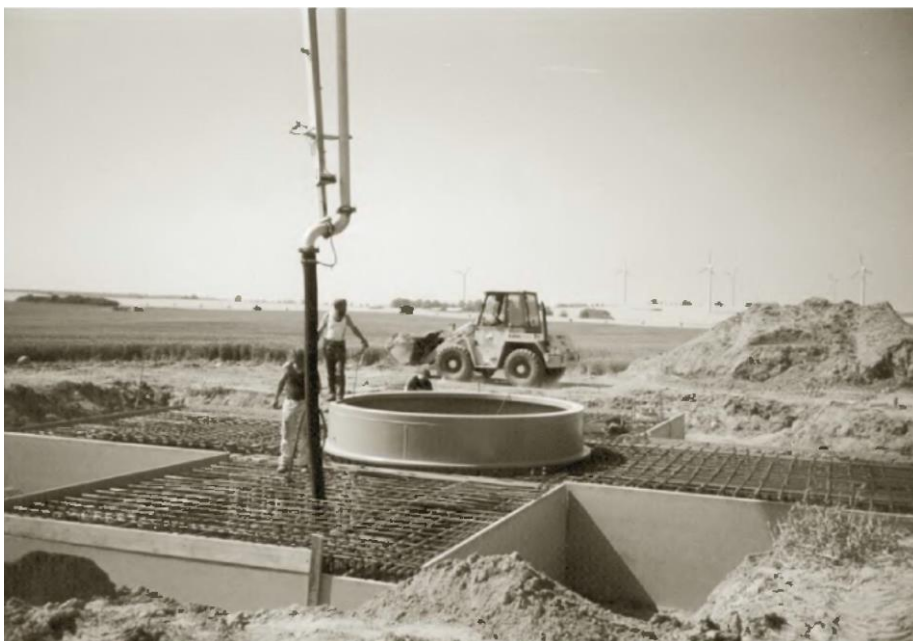
Σχήμα 1-18: Θεμελίωση μεγάλης εμπορικής ανεμογεννήτριας [1]
