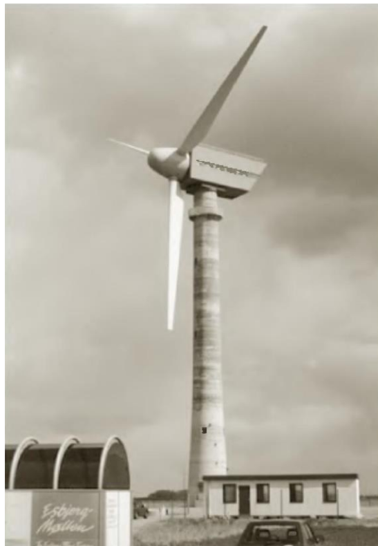
Σχήμα 1-8: Πυλώνας από οπλισμένο σκυρόδεμα πειραματικής ανεμογεννήτριας [1]
