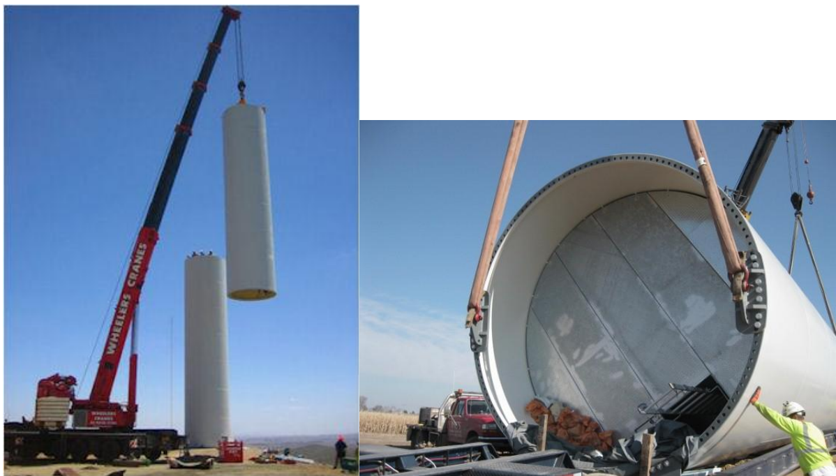
Σχήμα 1-14: Ανέγερση τμήματος πυλώνα (πηγή: www.windlab.com & diamondtowerservice.com )
