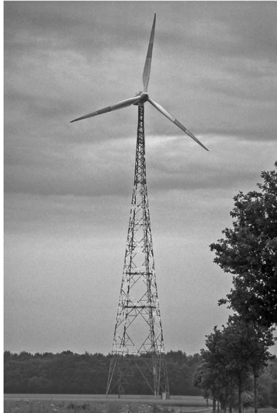
Σχήμα 1-7: Δικτυωτός πυλώνας ανεμογεννήτριας Vestas V80 [1]
