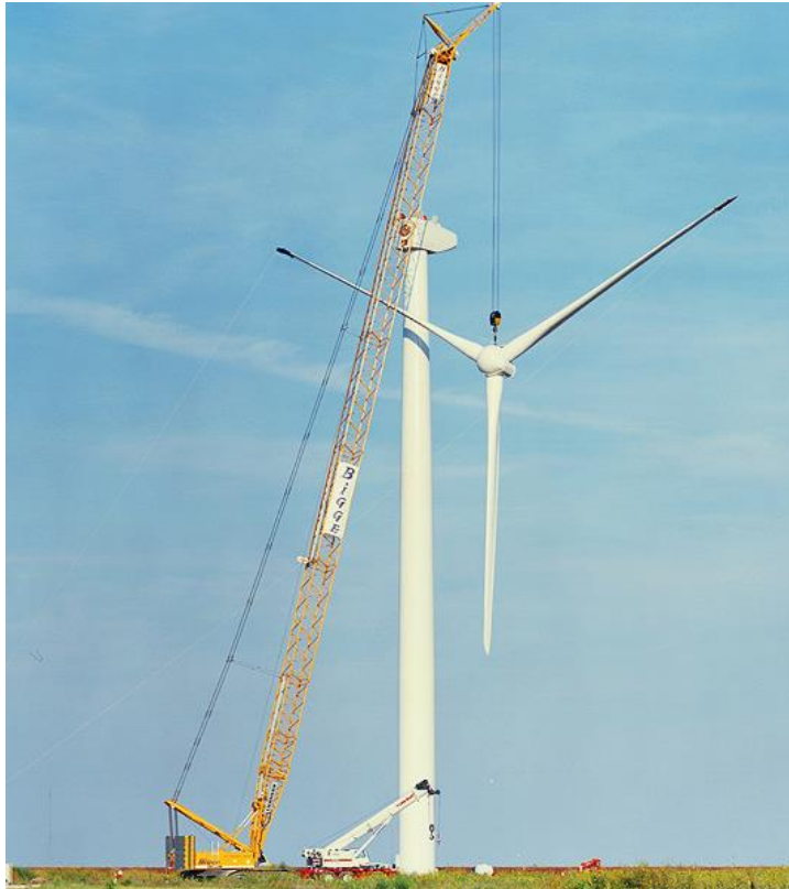
Σχήμα 1-15: Ανέγερση πτερυγίων (πηγή: www.bigge.com )
