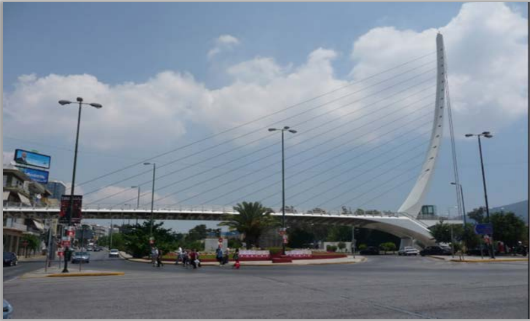
Εικόνα 8: Φωτογραφία της Πεζογέφυρας Calatrava (Πηγή [18])
