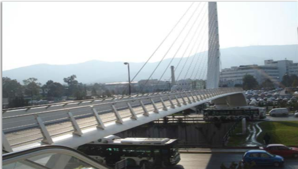
Εικόνα 7: Φωτογραφία της Πεζογέφυρας Calatrava (Πηγή [18])
