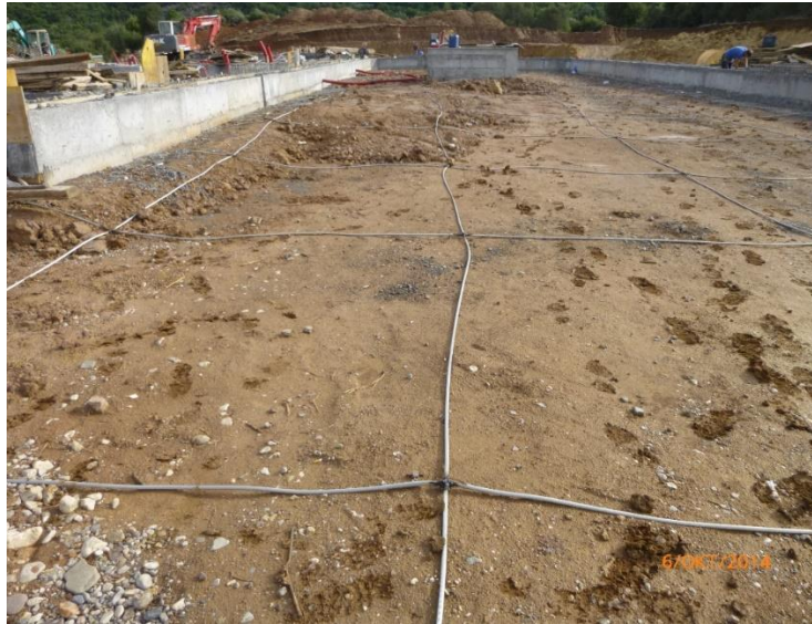
Εικόνα 6.1: Χωματοουργικές εργασίες για την τοποθέτηση πλέγμα γείωσης σε βάθος 0.70 m [40]
