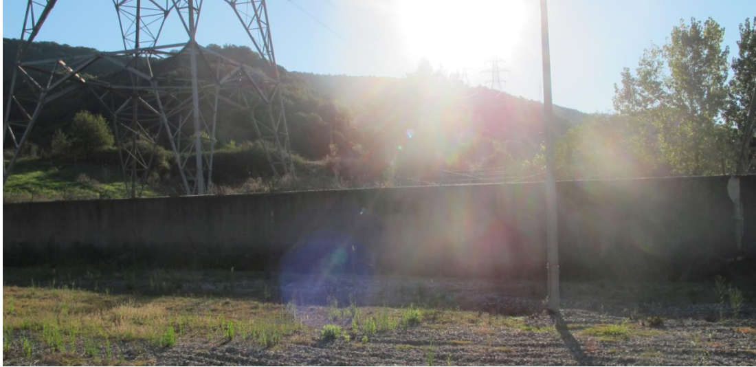
Εικόνα 5.4.8: Μονωτική χτιστή περίφραξη εσωτερικά των ορίων του πλέγματος γείωσης. [40].
