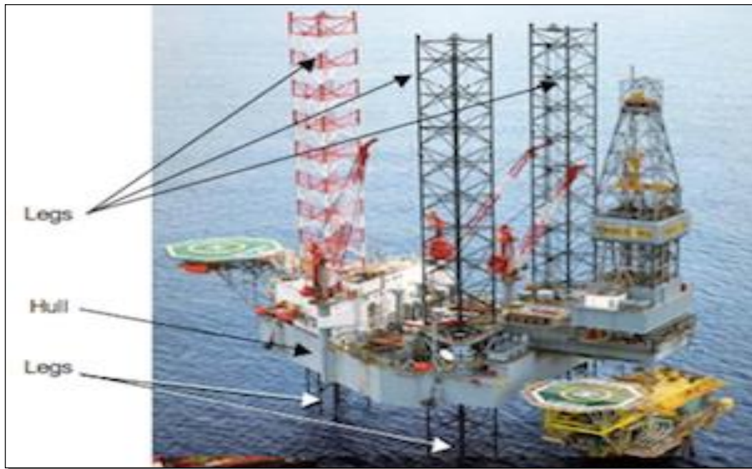
Σχήμα 26: Τυπική διάταξη μιας Jack-up
