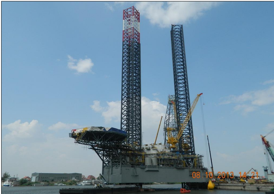
Σχήμα 25: Πλατφόρμα «Nerptune» κατασκευασμένη το 2013 με μέγιστο βάθος λειτουργίας τα 9.144 μέτρα, ανήκει στην εταιρεία «Eurasia Drilling» και δραστηριοποιείται στη Ρωσία
