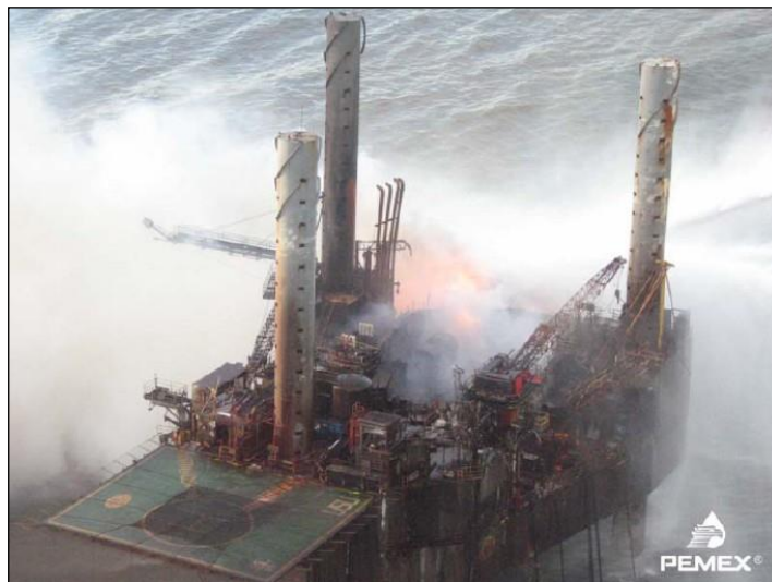
Σχήμα 51: Η πλατφόρμα μετά την κατάρρευση
