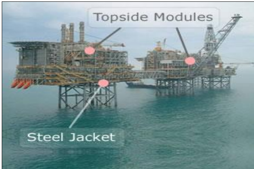
Σχήμα 7: Η συγκεκριμένη λειτουργεί στο κοίτασμα Buzzard στη Βόρεια Θάλασσα, στα βορειοανατολικά της Σκωτίας, αποτυπώνοντας την χαλύβδινη υποστήριξη των άνω στοιχείων της κατασκευής. Βάθος λειτουργίας 100 μέτρα
