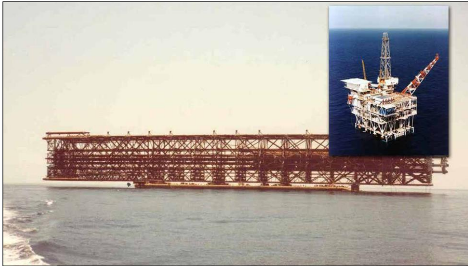
Σχήμα 16: Πλατφόρμα «Lena Guyed Tower»
