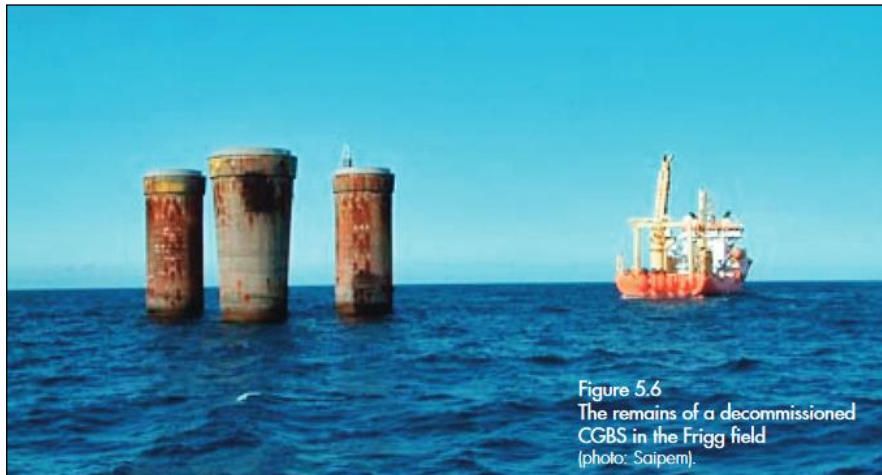
Σχήμα 14: Κατάλοιπα μιας πλατφόρμας Βαρύτητας της εταιρείας Saipem που λειτουργούσε στο κοίτασμα Frigg, στη Βόρεια Θάλασσα
