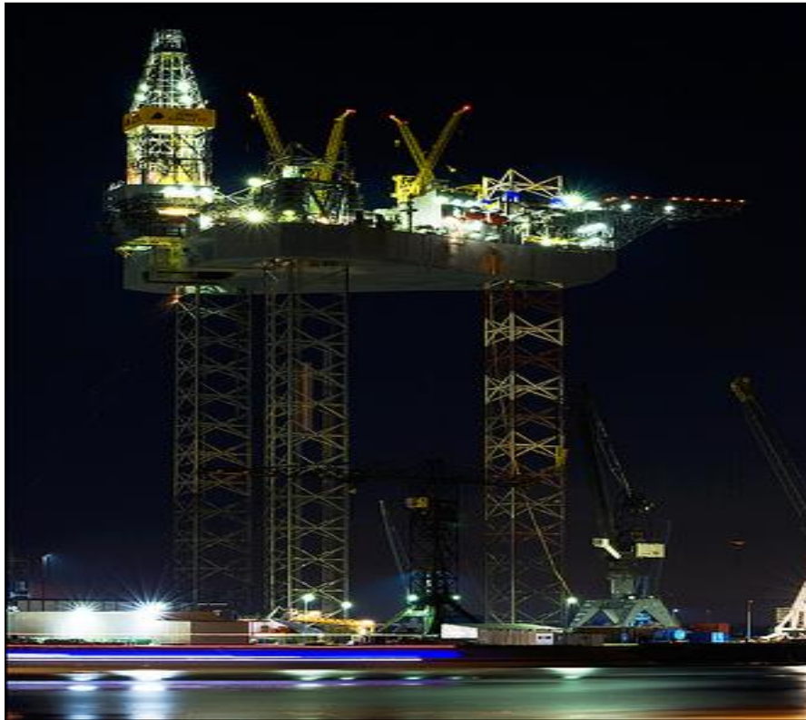
Σχήμα 28: Τα πέλδια της πλατφόρμας «Rowan Gorilla» η οποία δραστηριοποιείται βορειοδυτικά της Δανίας
