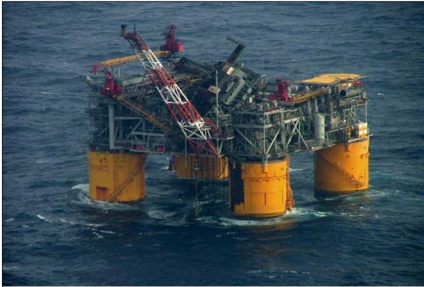
Σχήμα 19: Στη φωτογραφία παρατηρούμε την πλατφόρμα Mars να έχει υποστεί ζημιές από τον τυφώνα “Katrina” στον κόλπο του Μεξικού
