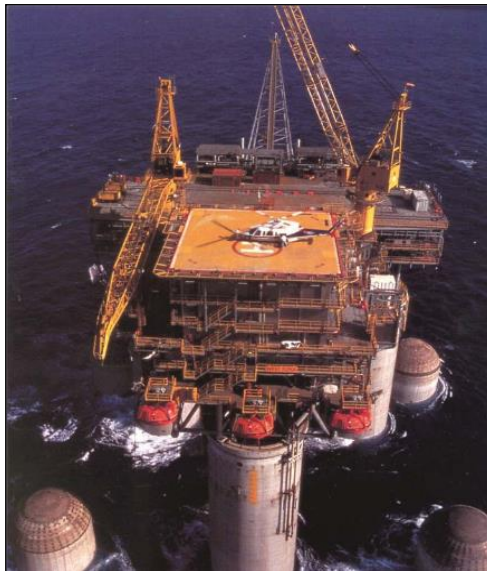
Σχήμα 11: Στην παρακάτω εικόνα παρατηρούμε μια πλατφόρμα αυτού του τύπου ονόματι της εταιρείας Echop που λειτουργεί στην Αυστραλία. Η κατασκευή βρίσκεται σε βάθος 61 μέτρων.
