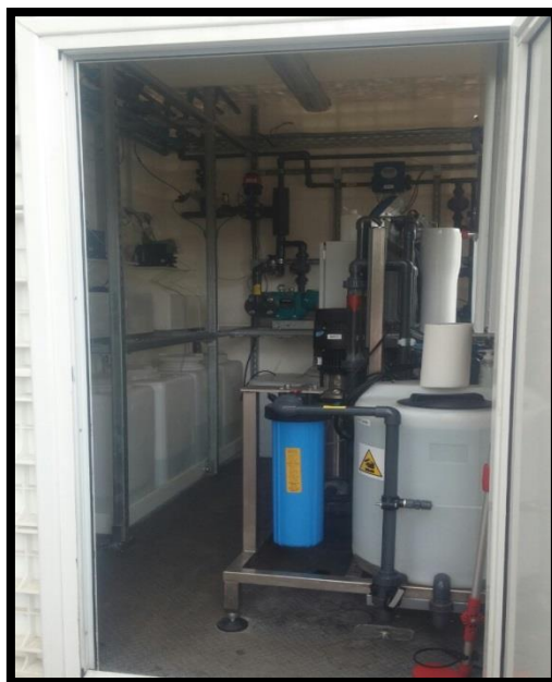
Σχήμα 4-13: Μονάδα αντίστροφης όσμωσης
