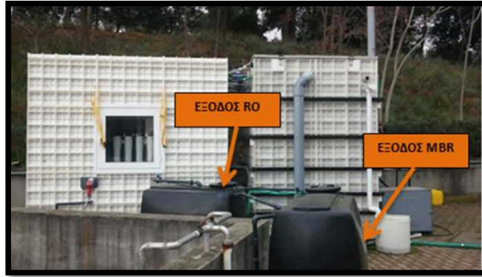
Σχήμα 4-26: Οι δεξαμενές συλλογής των νερών εξόδου από τον MBR και την RO
