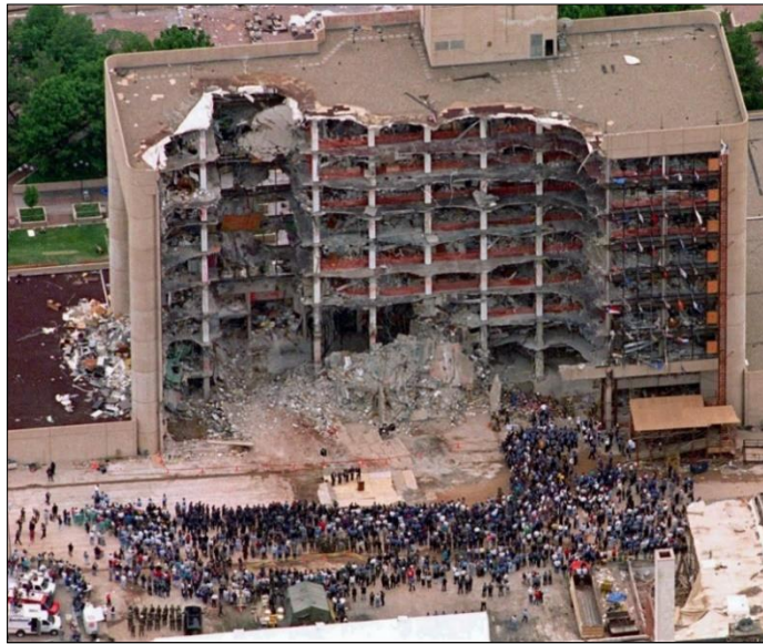
Εικόνα 1-9: Κατάρρευση του Alfred P. Murrah Federal Building [Πηγή: aol].
