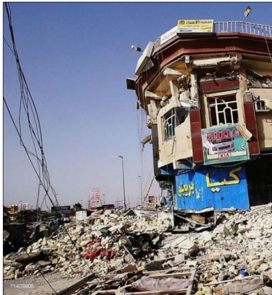
Εικόνα 1-8: Κατάρρευση κτιρίων στην Sadr του Ιράκ [Πηγή: gettyimages].
