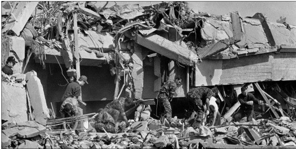
Εικόνα 1-5: Κατάρρευση κτιρίου στο Beirut του Λιβάνου [Πηγή: Huffingtonpost].
