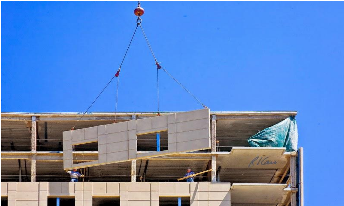
Σχ. 1.7: πανέλο πλαγιοκάλυψης με ανοίγματα κατά την ανέγερση
