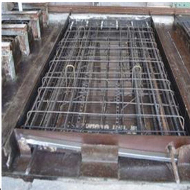
Σχ. 1.16: Σύνδεση με προεξέχουσες ράβδους (α) εφαρμογή σε πάνελο, (β) κατακόρυφη τομή [19]
