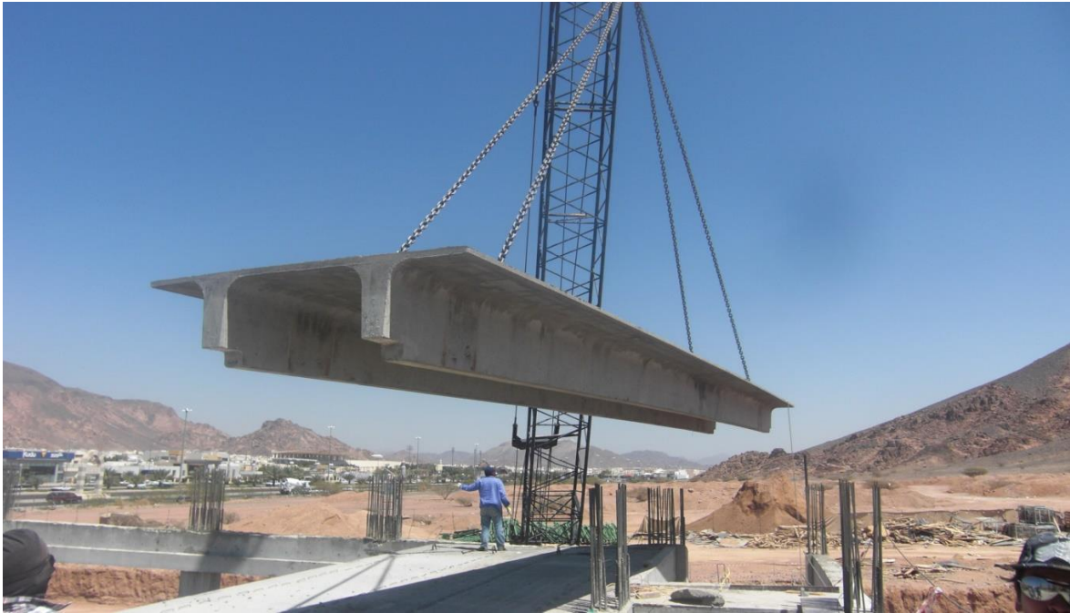
Σχ. 1.3: δοκός διπλού T υπό ανέγερση
