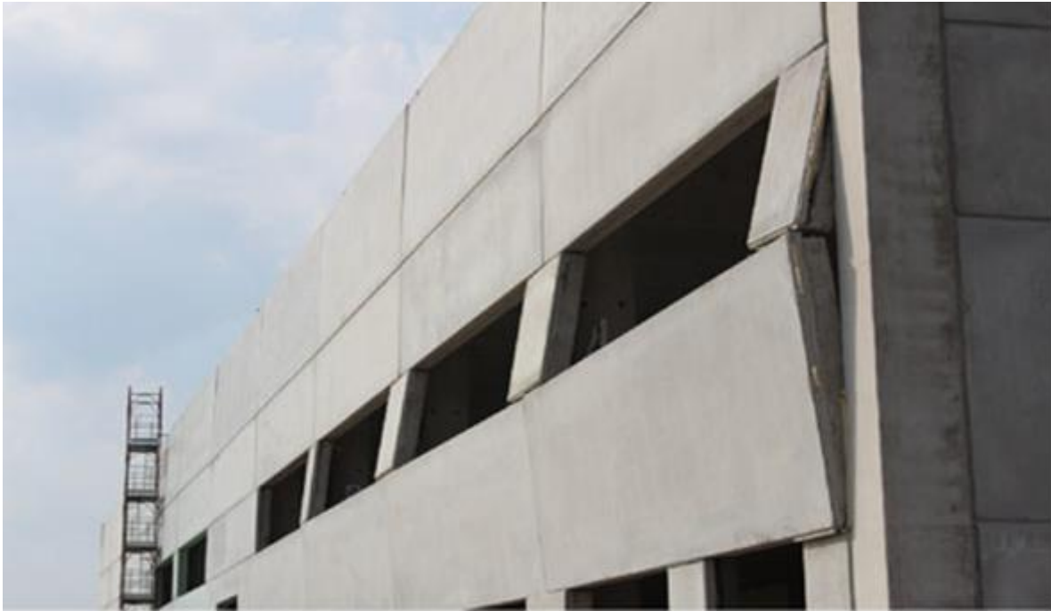
Σχ. 1.27: Εκτός-επιπέδου ανατροπή πανέλων πλαγιοκαλύψεων [15]
