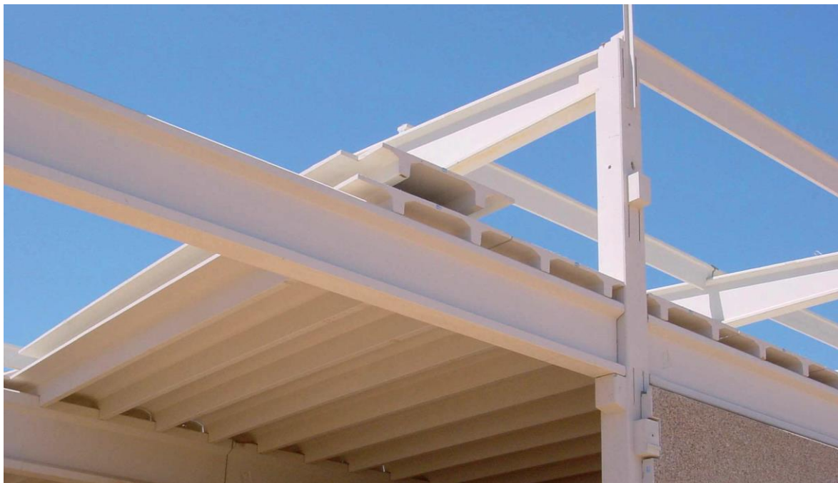
Σχ. 1.4: δοκοί διπλού T κατά την τοποθέτηση στην τελική τους θέση (οροφή)
