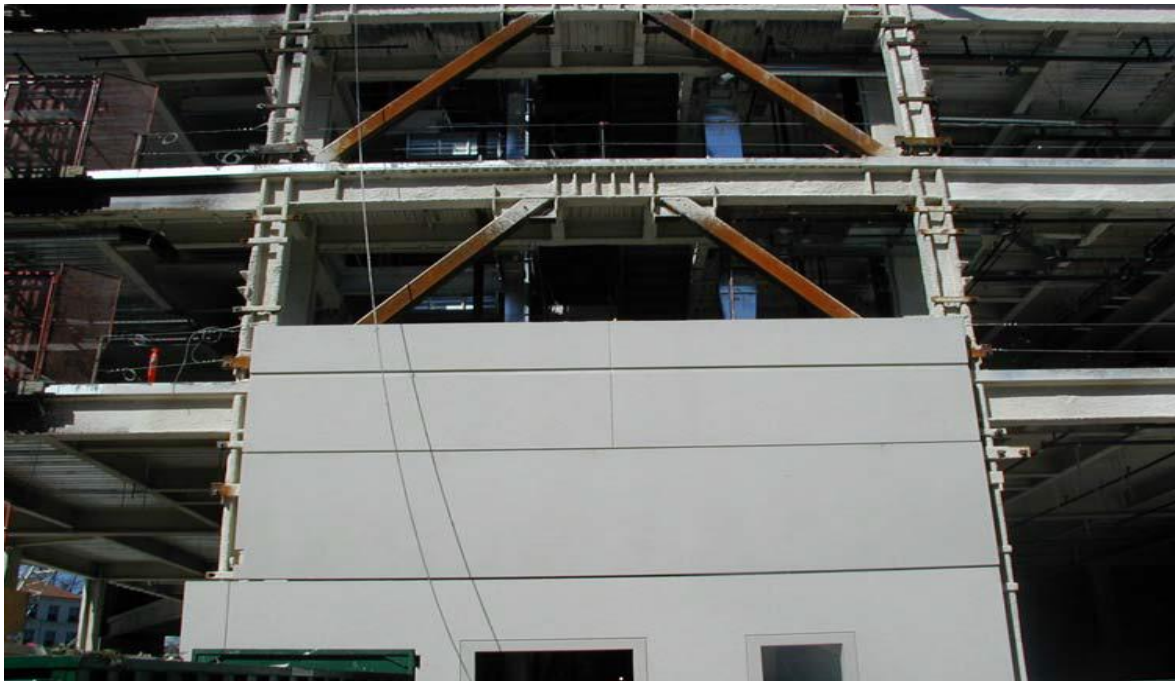
Σχ. 1.6: πανέλο πλαγιοκάλυψης συνδεδεμένο με το φέροντα οργανισμό
