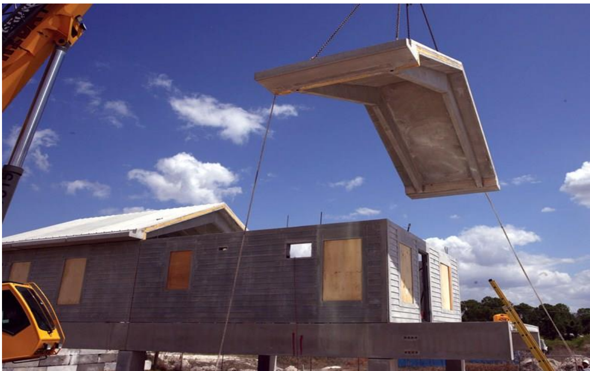
Σχ. 1.1: Ανέγερση μονώροφης κατοικίας με προκατασκευασμένα στοιχεία
