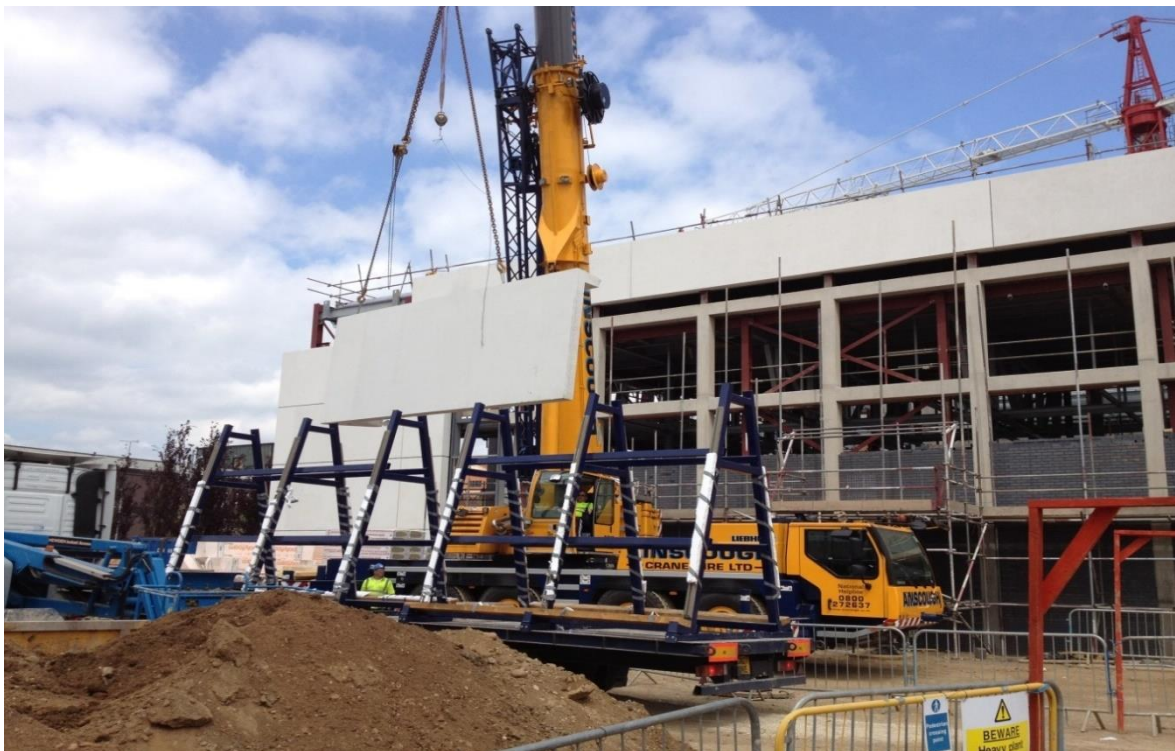
Σχ. 1.21: Ανέγερση πανέλου από όχημα ανύψωσης, αμέσως μετά τη μεταφορά του στο εργοτάξιο
