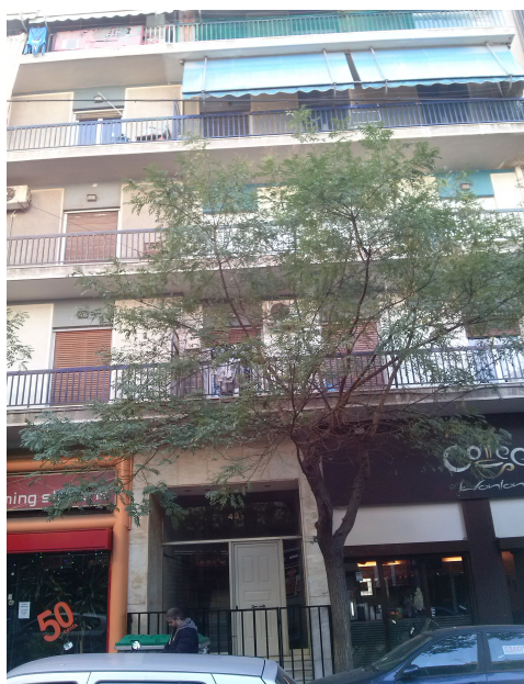
Εικόνα 16: Εξωτερική όψη πολυκατοικίας στην οδό Ηπείρου 43 Πηγή: Προσωπικό αρχείο
