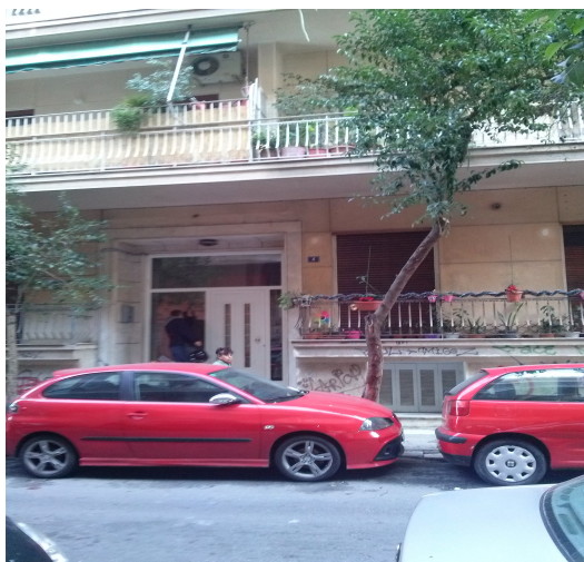
Εικόνα 5: Εξωτερική όψη πολυκατοικίας στην οδό Αγ. Μελετίου 4Α Πηγή: Προσωπικό αρχείο
