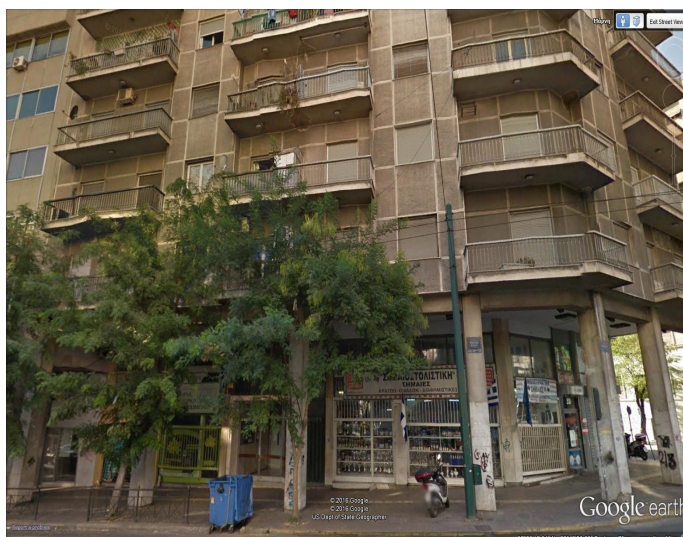
Εικόνα 34: Εξωτερική όψη πολυκατοικίας στην οδό Μάρνης 32 Πηγή: Google Earth
