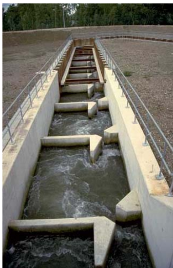
Σχήμα Β - 10: Δίοδος ιχθύων με vertical slot (αριστερά), TUM-Hydro Shaft Power Plant Prototype (δεξιά), [source: (FAO, 2001), (Rutschmann, et al., 2016)]
