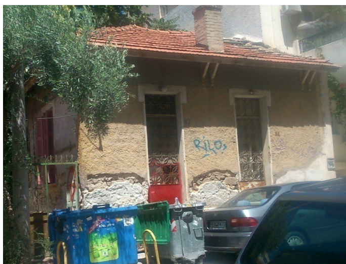
Εικόνα 4.7 – Το κτίσμα του οικοπέδου 050580147010 (επί της οδού Ηρώων Πολυτεχνείου)
