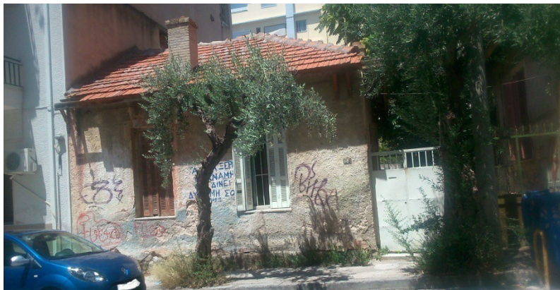
Εικόνα 4.6 – Το κτίσμα του οικοπέδου 050580147011 (επί της οδού Ηρώων Πολυτεχνείου)
