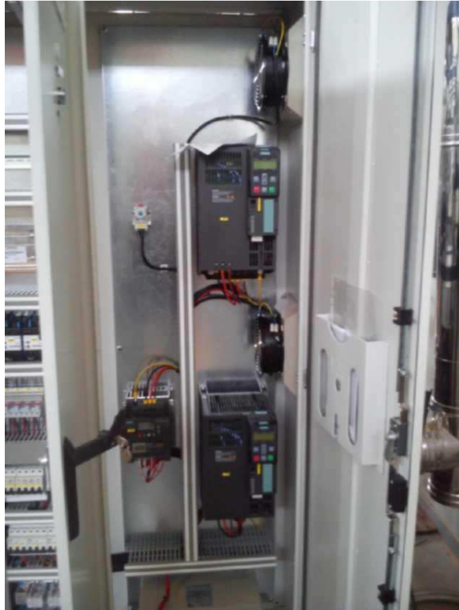
Εικ. 2.13. Οι ρυθμιστές στροφών της εγκατάστασης. Στα αριστερά ο ρυθμιστής στροφών της αντλίας και στα δεξιά οι δύο ρυθμιστές στροφών των γεννητριών
