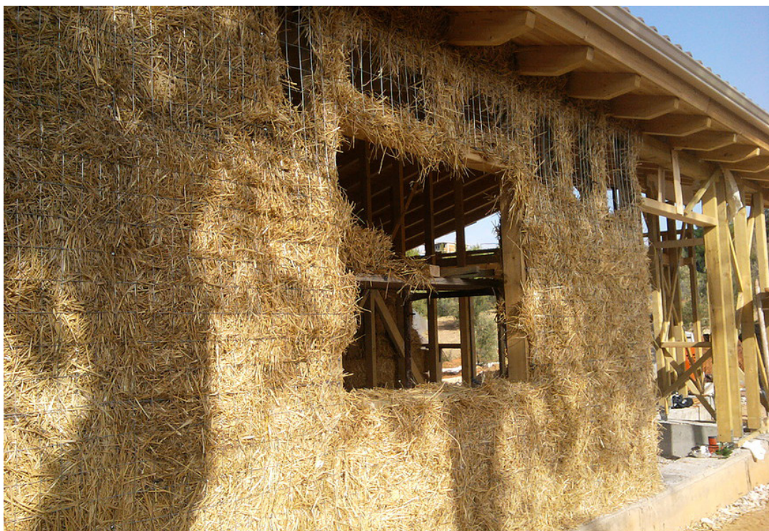
Εικόνα 3.1.2 Κατοικία στον Ωρωπό - Στάδιο κατασκευής
