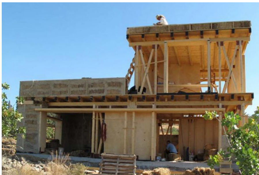
Εικόνα 3.1.1 Κατοικία στην Αίγινα - Στάδιο κατασκευής
