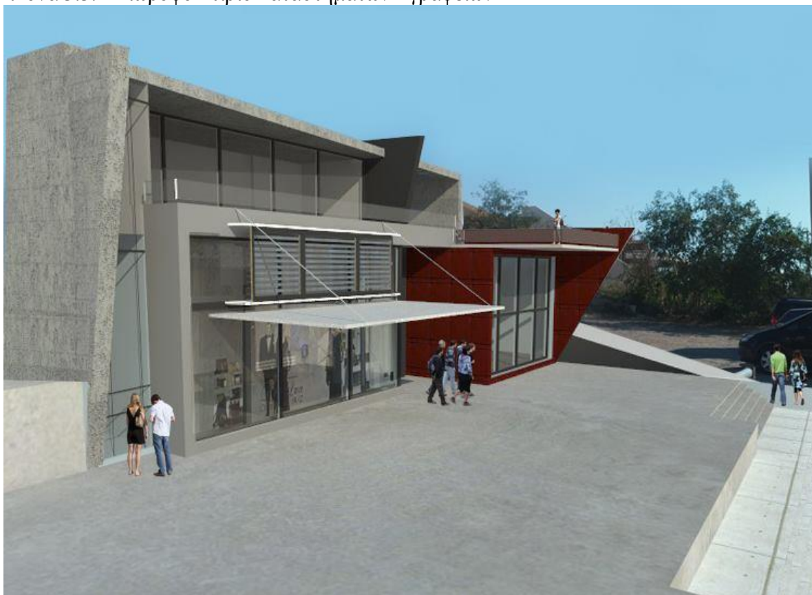
Εικόνα 3.3.2 Διώροφο κτίριο καταστημάτων - γραφείων
