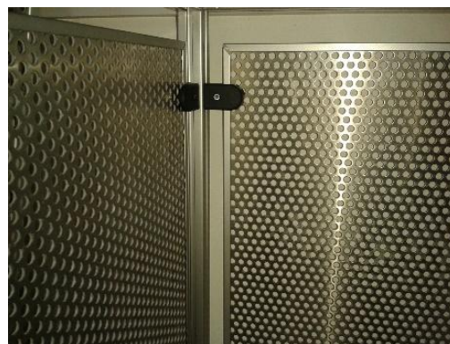
Εικόνα 2.64 Στερέωση πλαϊνών φύλλων αλουμινίου
