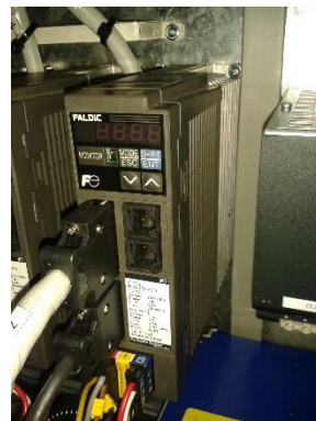
Εικόνα 3.2 Βαθμίδα ενίσχυσης σερβοκινητήρα
