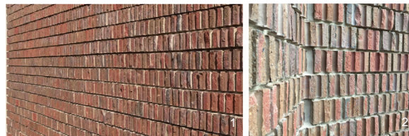
1,2 | Λεπτομέρειες της νέας (1) και υφιστάμενης (2) χρήσης του τούβλου στις όψεις των κτιρίων
