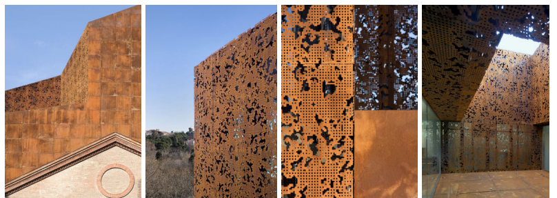
1-4 | Εσωτερικές και εξωτερικές απόψεις της μεταλλικής διάτρητης επιφάνειας από φύλλα χυτοσιδήρου που λειτουργεί ως φίλτρο του φυσικού και τεχνητού φωτός
