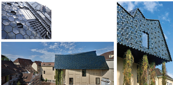
1 | Λεπτομέρεια κατασκευής της επικάλυψης της νέας στέγης
