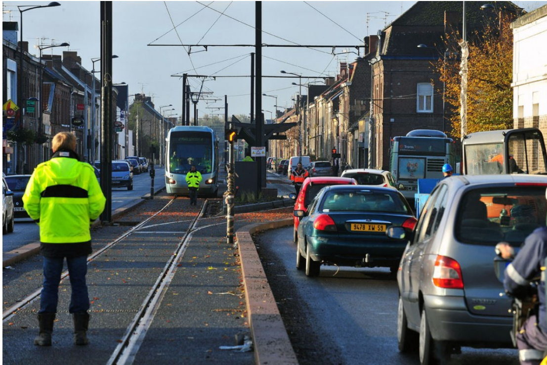
Φωτογραφία 8. Δίκτυο τραμ μονής λωρίδας με σημεία διασταυρώσεων στη Βαλενσιέν στη Γαλλία κατά την κατασκευή του (Αύγουστος 2013).
