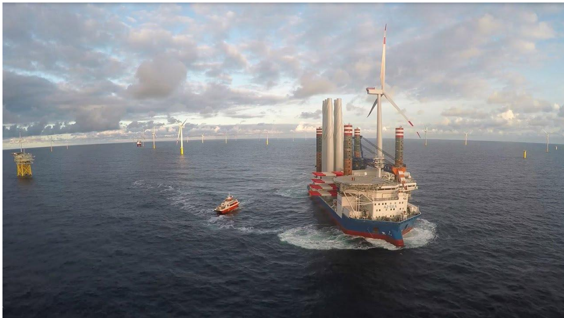
Εικόνα 24 : Η εγκατάσταση των ανεμογεννητριών στο υπεράκτιο αιολικό πάρκο στην περιοχή Borkum Riffgrund της Βόρειας Θάλασσας
