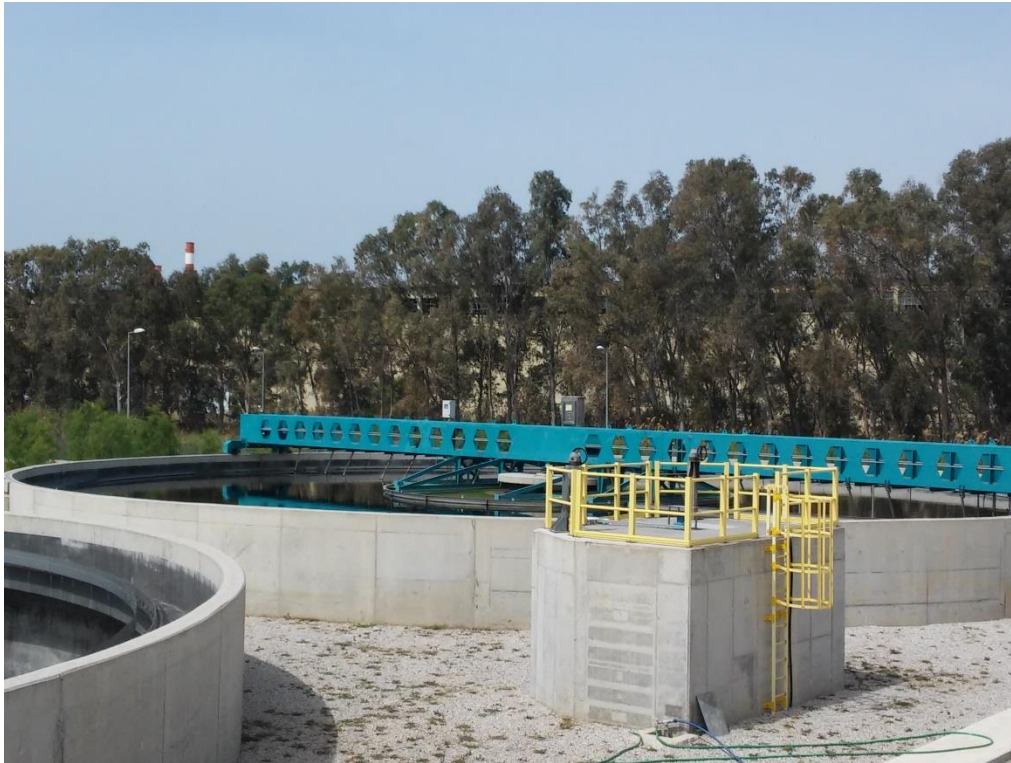
Εικόνα 6.3. Άποψη δεξαμενής καθίζησης
