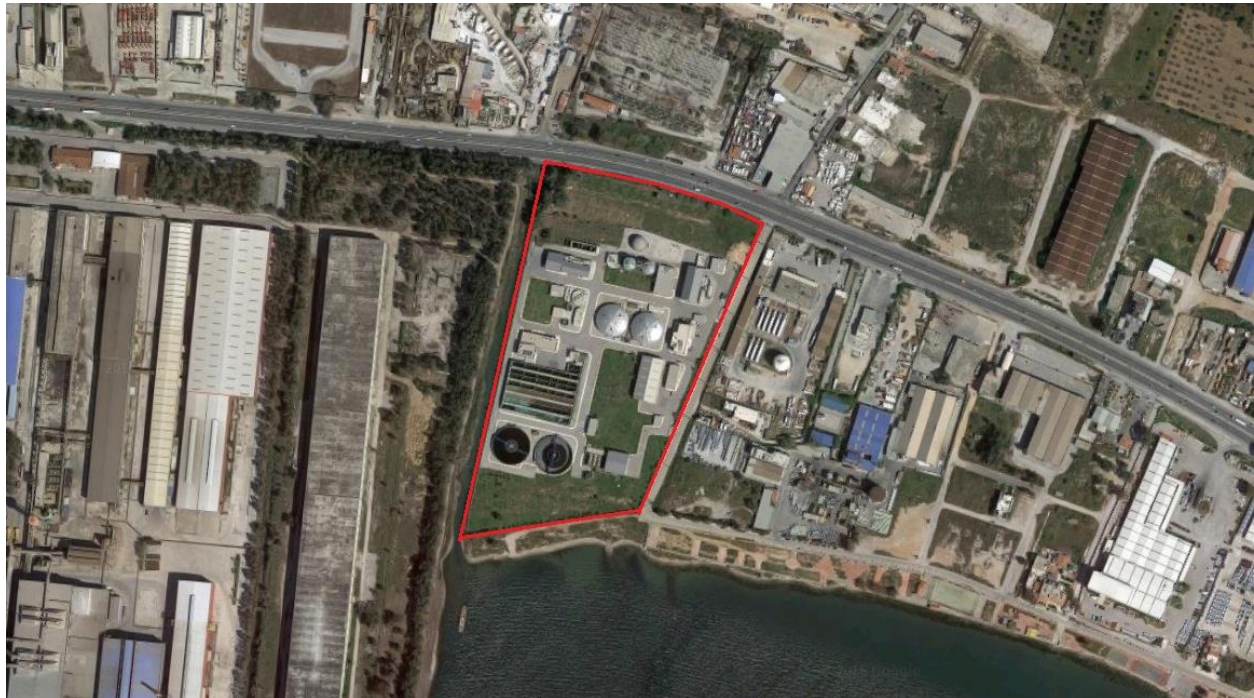
Εικόνα 6.1. Κέντρο Επεξεργασίας Λυμάτων Θριασίου (πηγή : Google Earth)
