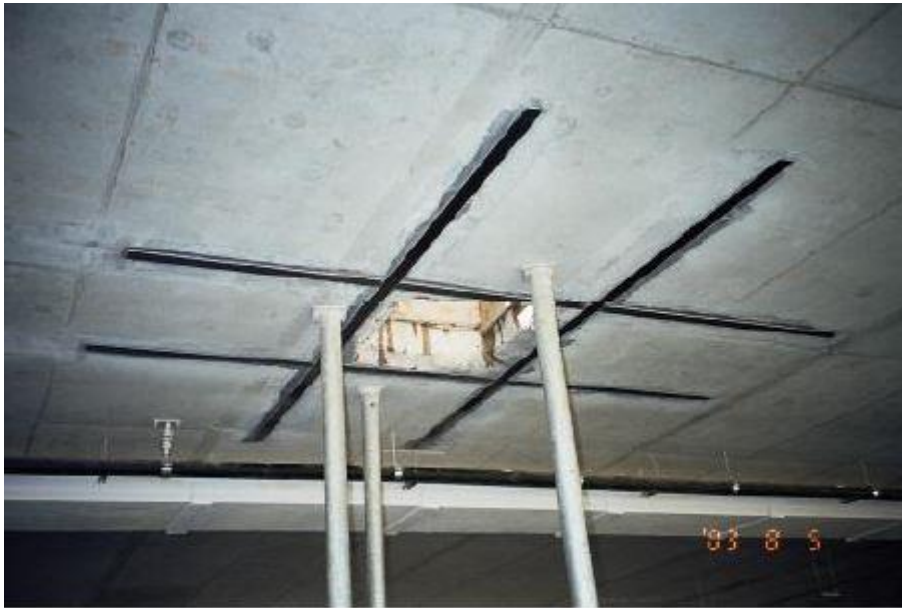
Σχήμα 5.19 Διάταξη ενίσχυσης από FRP σε οπές πλακών
