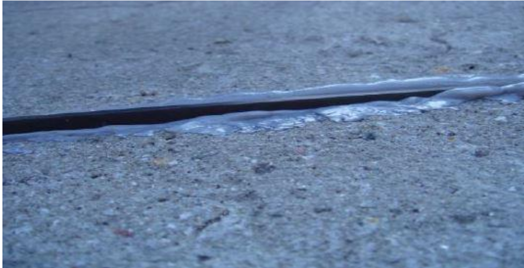
Σχήμα 5.8 Σύνθετο έλασμα σε εγκοπή
