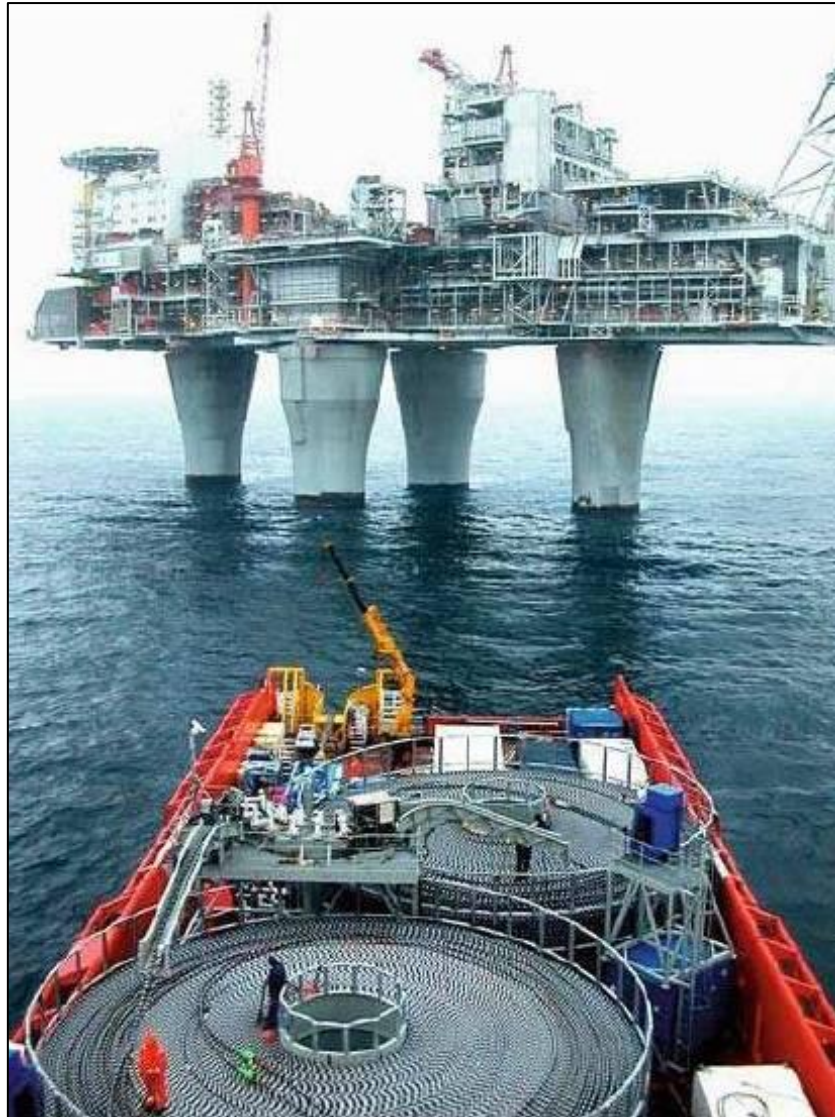
Εικόνα 2-3: Η νορβηγική πλατφόρμα εξόρυξης φυσικού αερίου “Troll A” παραλαμβάνει την ηλεκτρική του ενέργεια από ζεύγος HVDC καλωδίων.
