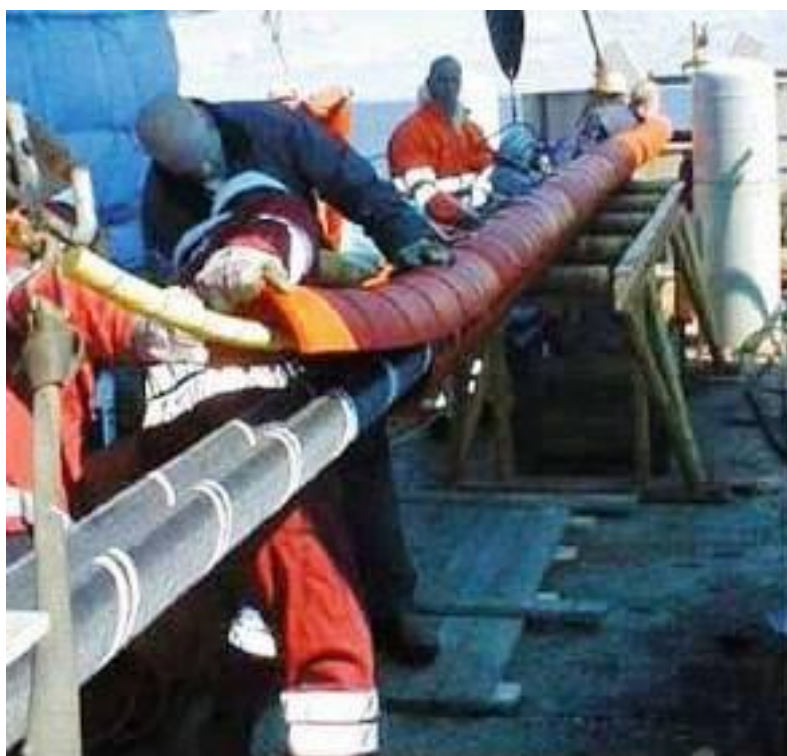
Εικόνα 2-20: Προστατευτικά πλαστικά κελύφη συνδέονται με δύο HVDC καλώδια και ένα καλώδιο οπτικής ίνας προτού το σύνολο των καλωδίων ποντιστεί.
