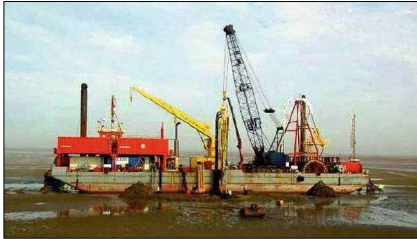
Εικόνα 2-10: Φορηγίδα επίπεδου πυθμένα κινητοποιείται για πόντιση καλωδίου σε παλιρροιακές πεδιάδες.
