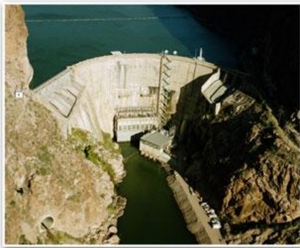
Εικόνα 3.15 : Το φράγμα Horse Mesa [20]
