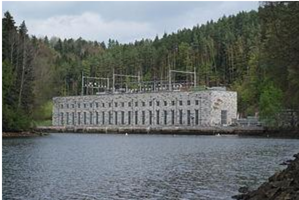
Εικόνα 3.17: Σταθμός αντλησιοταμίευσης Reisach [20]
