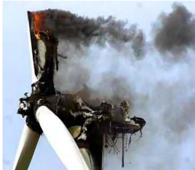
Σχήμα 1.13: Καταστροφή ανεμογεννήτριας λόγω εσφαλμένης αντικεραυνικής προστασίας [4]
