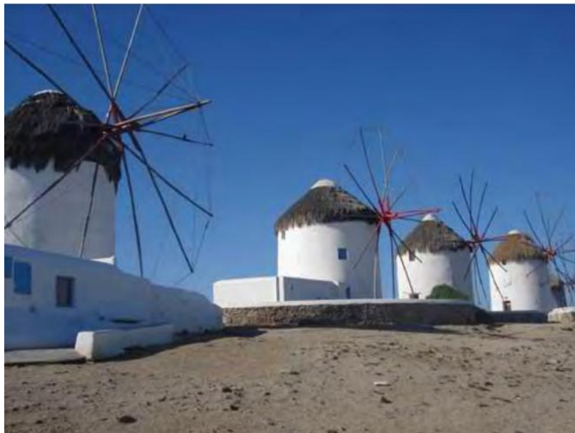
Σχήμα 1.2: Ανεμόμυλοι στο νησί της Μυκόνου
