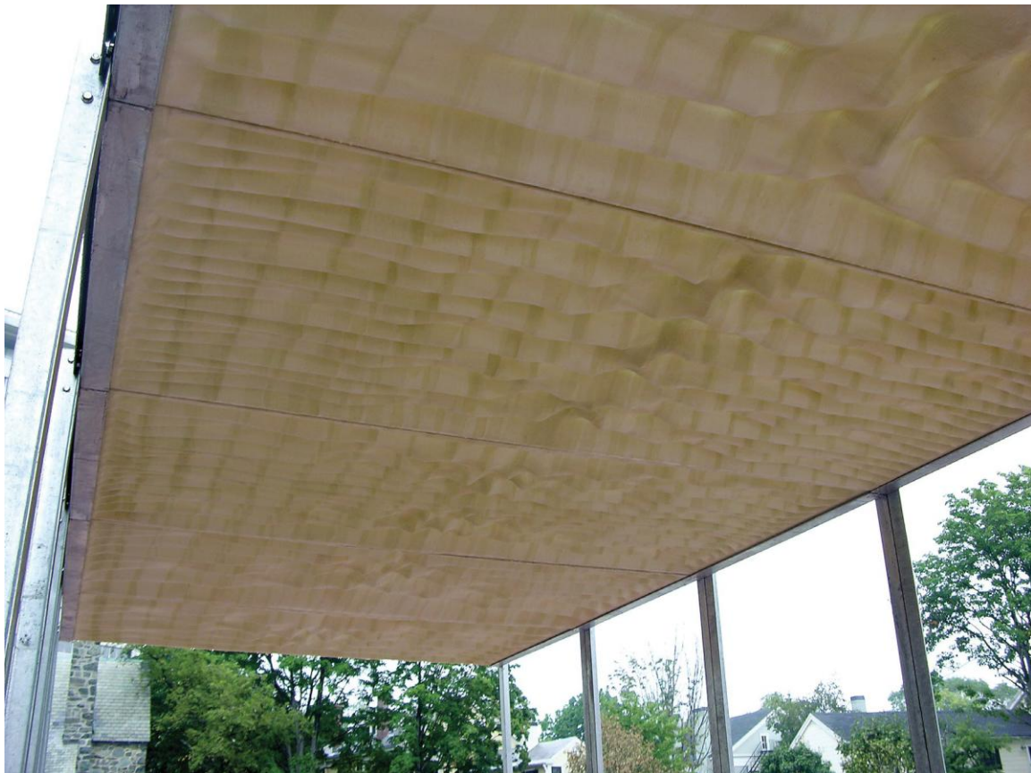
Η στέγη του Prototype Pavilion, MOS το 2005 κατασκευάστηκε με τεχνική Forming.
