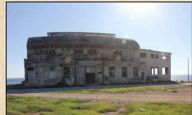
Το κτίριο ηλεκτροδότησης των Λιπασμάτων
