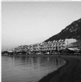
Κτισμένο παραλιακό μέτωπο
