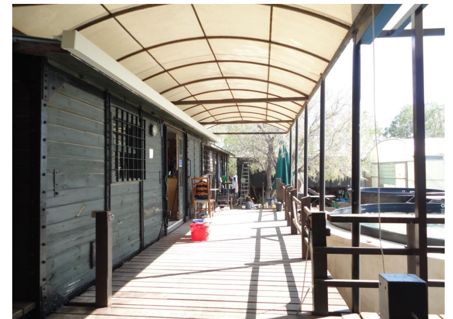
Εικόνα 36: Εσωτερικός διάδρομος Κέντρου Διάσωσης
