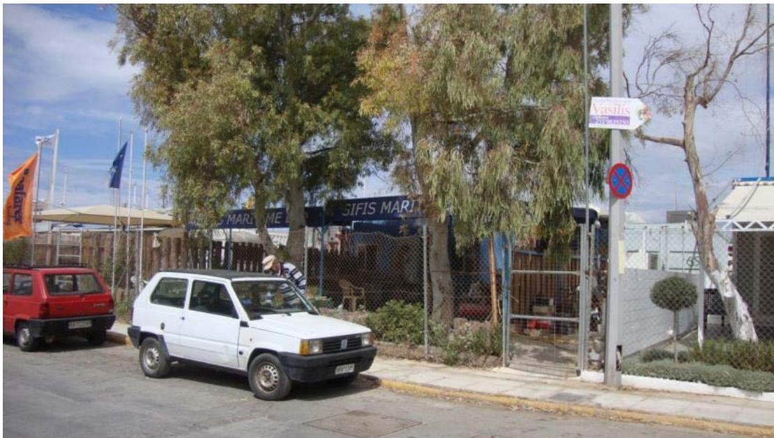
Εικόνα.6.Αυθαίρετες λυόμενες κατασκευές και τροχόσπιτα πλησίον του χώρου χερσαίας απόθεσης.
