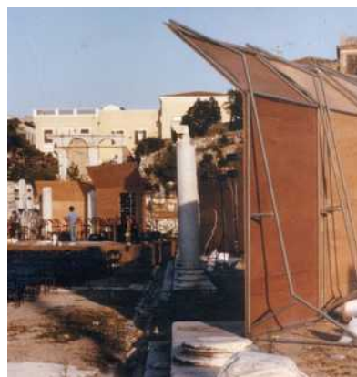
3.3 .19 Ανακλαστήρες με σχήμα αμβλείας γωνίας σε υπαίθρια συναυλία στη Ρωμαϊκή Αγορά. Μελέτη: Μόσχος, Κ, Σούμπερτ, Γκ.
