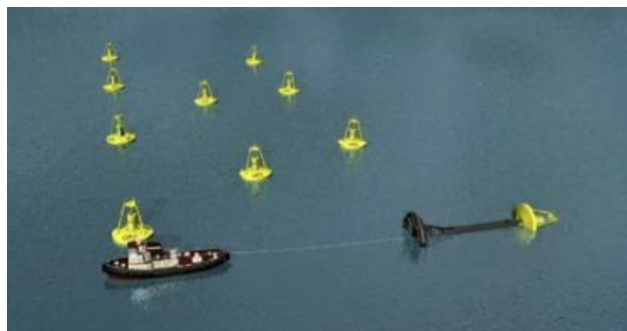
Σχήμα 8.5: Μεταφορά συσκευών στη θέση εγκατάστασης (Πηγή: OceanPowerTechnologies)
