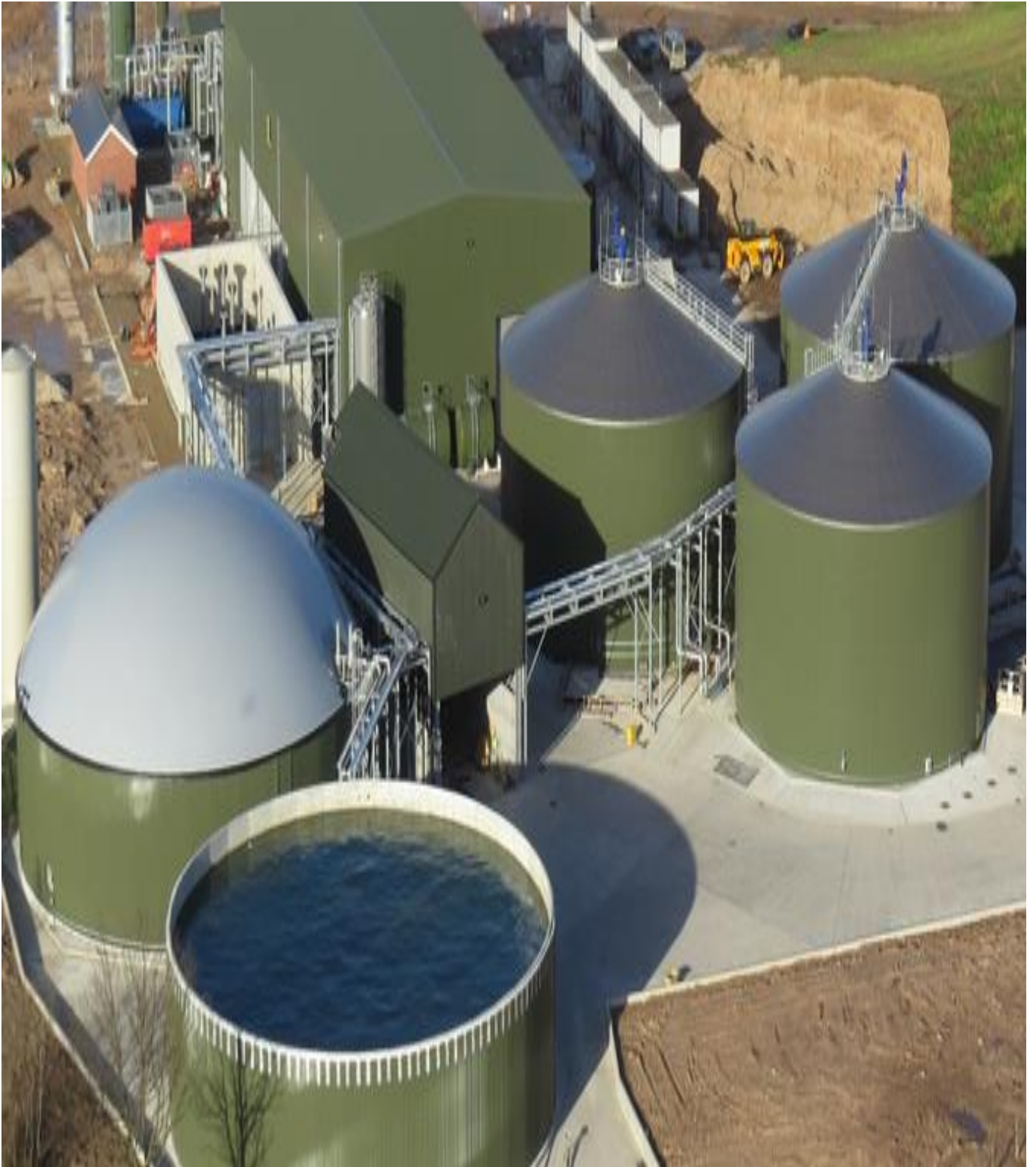
Εικόνα 1: Φωτογραφία από μονάδα επεξεργασίας κτηνοτροφικών αποβλήτων για παραγωγή βιοαερίου στο Retford της Αγγλίας
