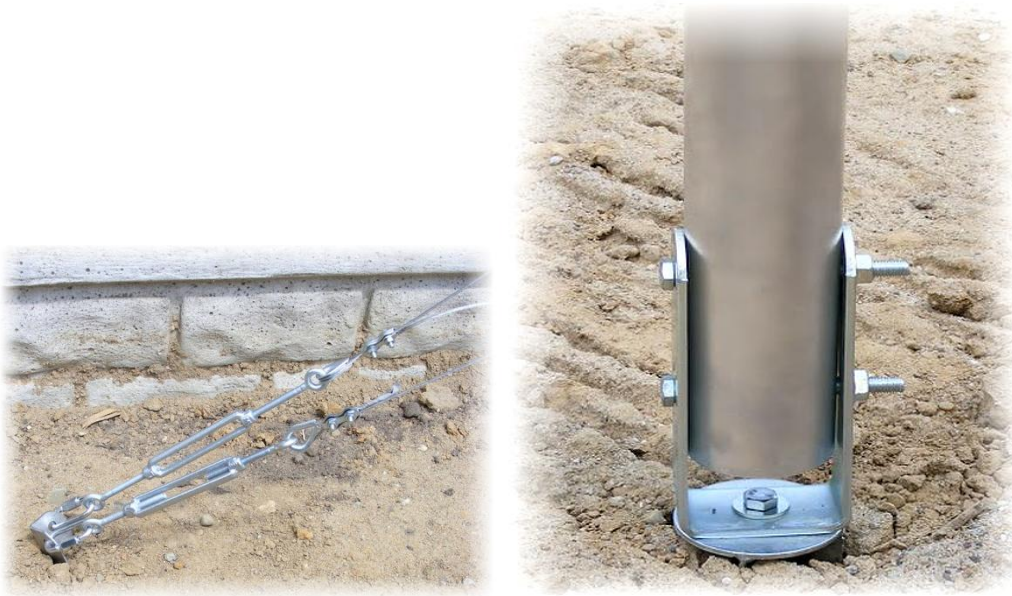
Σχήμα 6.5. Βάση πυλώνα – βάσεις αντηρίδων
