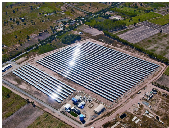
Σχήμα 1.7. Εγκατάσταση ηλεκτροπαραγωγής με κοίλα κάτοπτρα (BINE, 2013)
