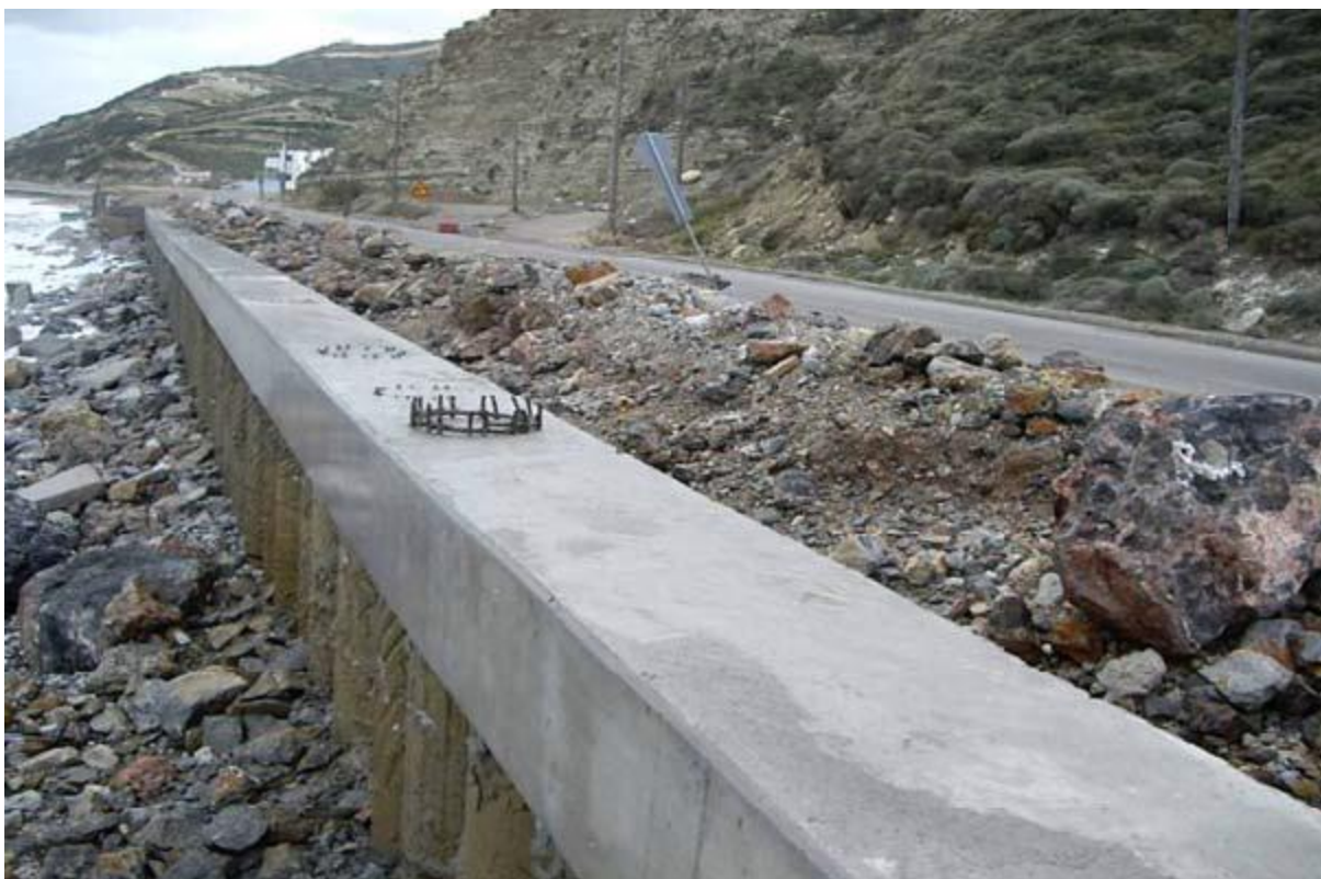
Εικόνα 0-12 Ο νέος τοίχος του δρόμου και η αντιστήριξη από φρεατοπασσάλους (Ηλία, 2013).
