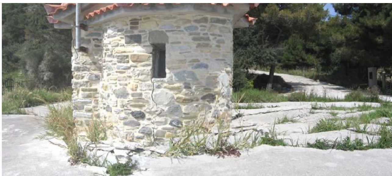
Εικόνα 0-20 Οι ρωγμές στον προαύλιο χώρο και στην ανωδομή του εξωκλησίου της Αγ. Μαρίας ( Ηλία, 2013).
