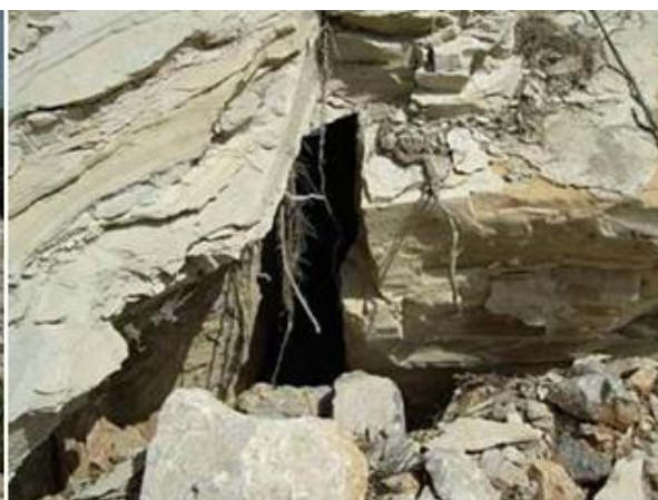
Εικόνα 0-15H έντονη χαλάρωση των ασβεσιτικών μαργών στο τεχνητό πρανές του δρόμου (Ηλία, 2013)
