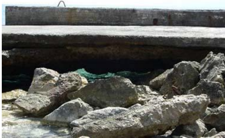
Εικόνα 0-19 Το ατελές λιμενικό έργο εσωτερικά του κρηπιδώματος (Ηλία, 2013).
