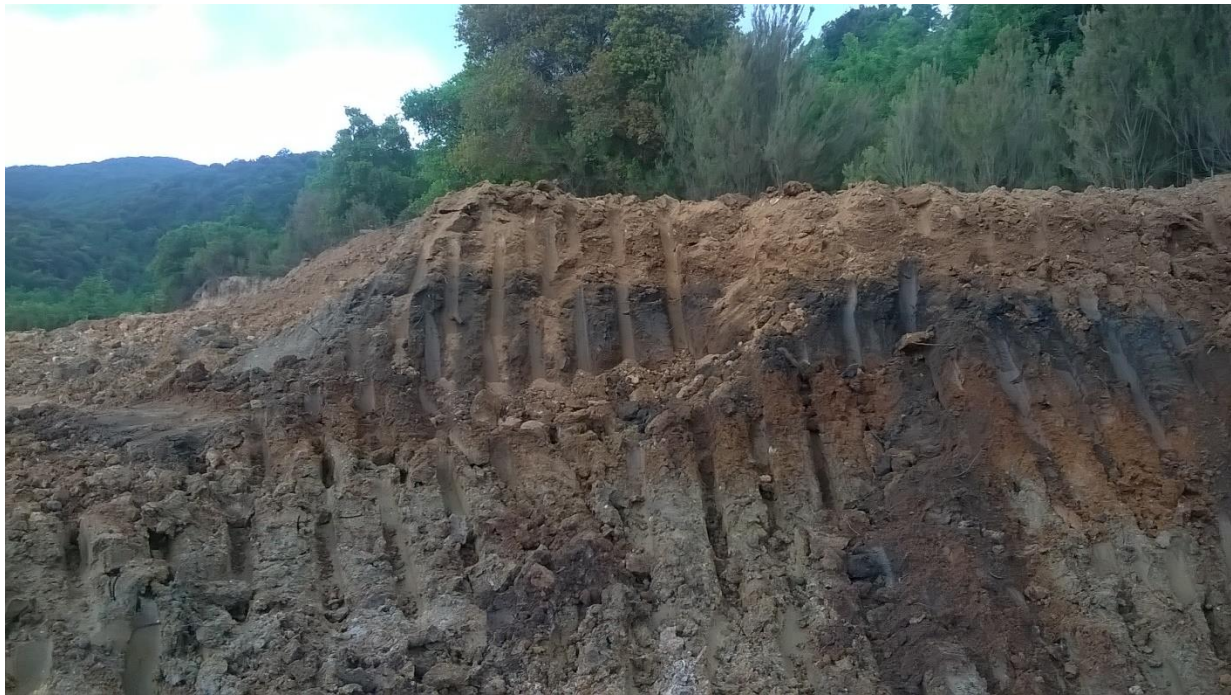
Εικόνα 6.4 : Φακοειδείς σχηματισμοί λόγω επικαλύψεων κατά την διαμόρφωση της απόθεσης
