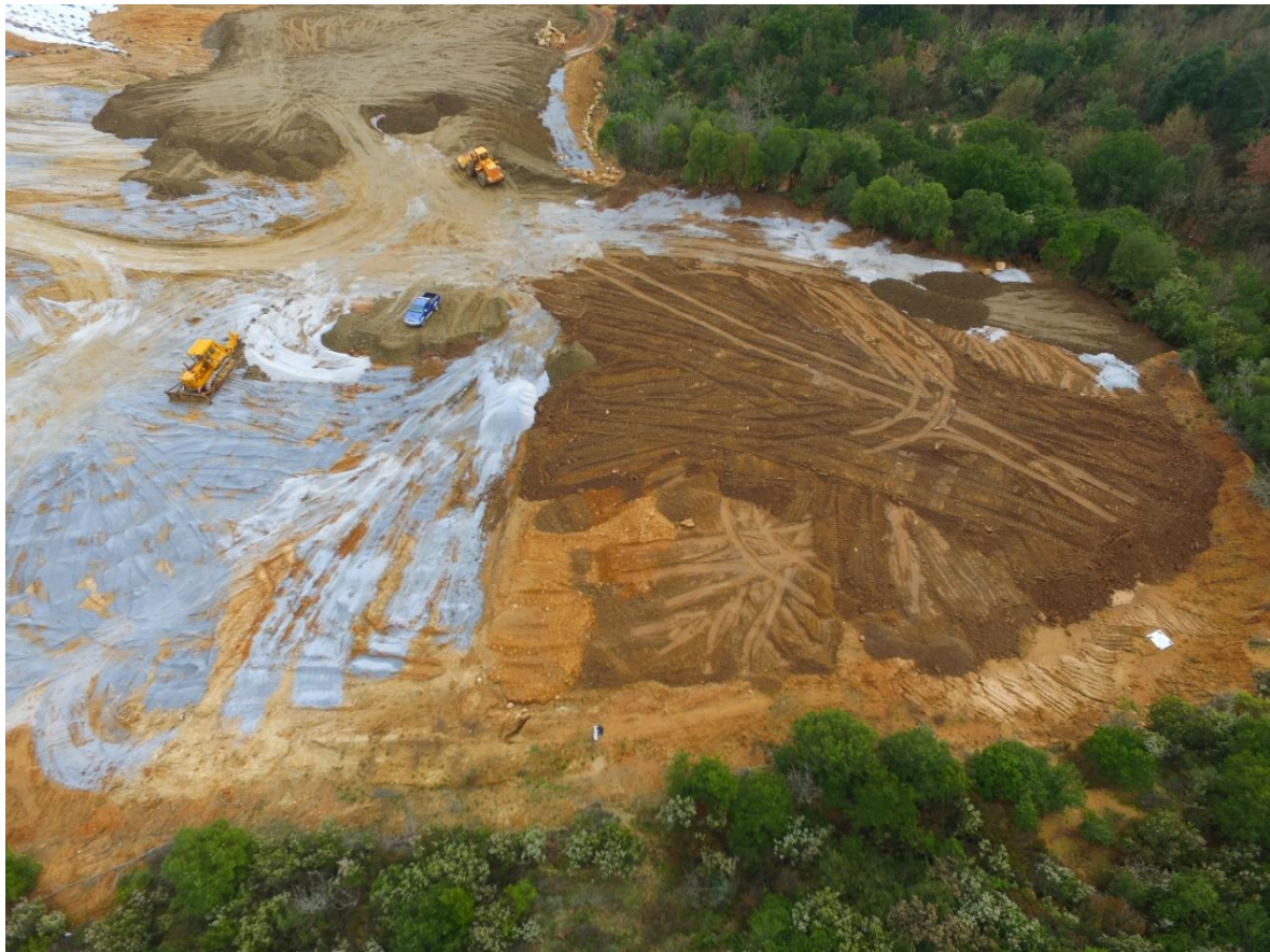
Εικόνα 6.7 : Διαδικασία προσθήκης ανθρακικού ασβεστίου και εδαφικού υλικού
