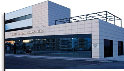
Ανέγερση νέου κτιρίου ΚΤΕΛ
