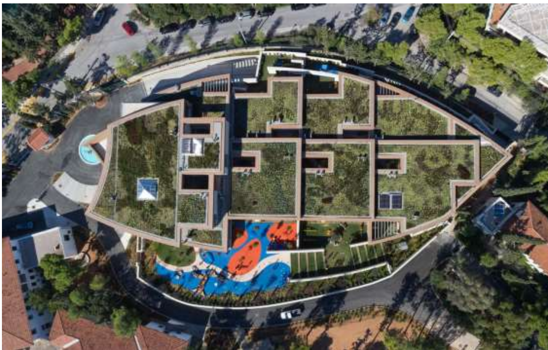
Εικόνα 9: Πρότυπο Νηπιαγωγείο «Ιωάννης Μ. Καρράς»_άποψη από ψηλά
