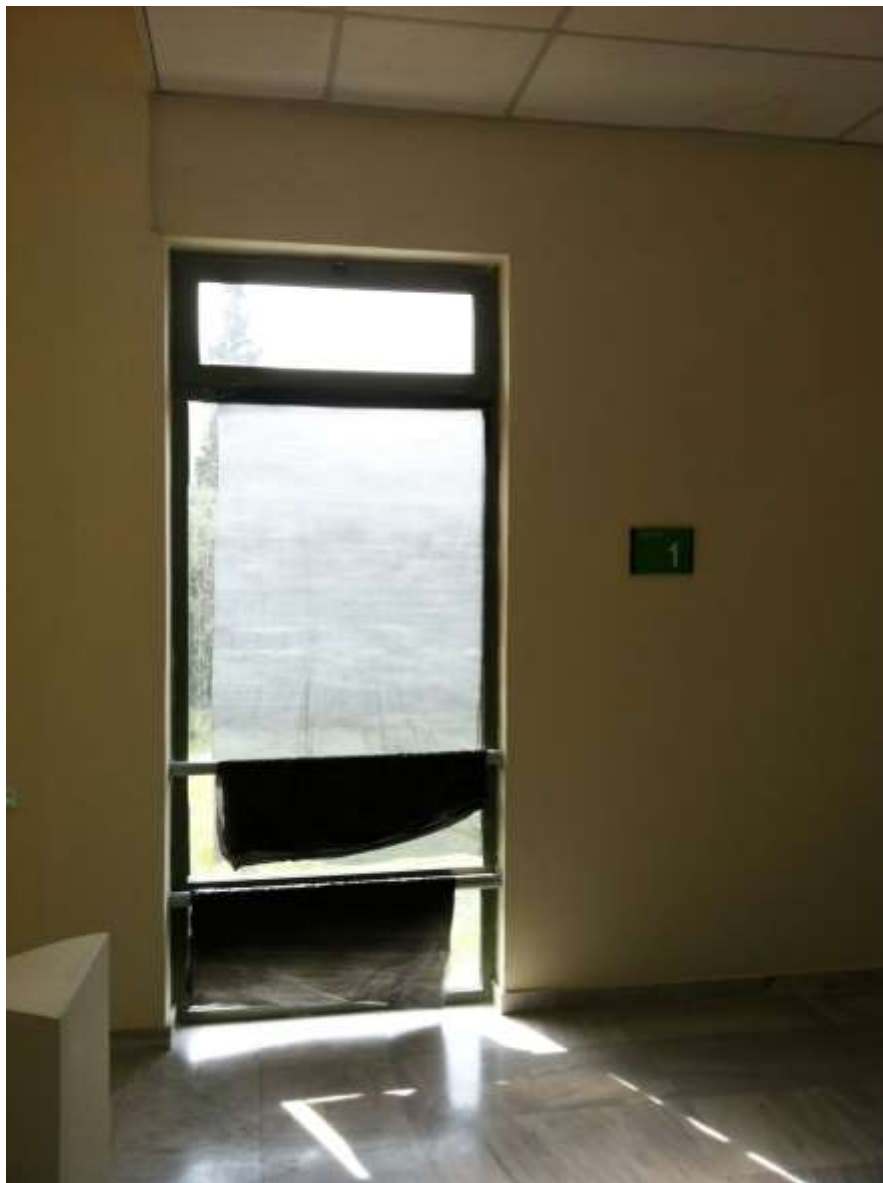
Εικόνα 105: Αυτοσχέδιος τρόπος σκίασης στο κλιμακοστάσιο της νοτιοανατολικής πλευράς του κτηρίου της Σ.Ε.Μ.Φ.Ε.
