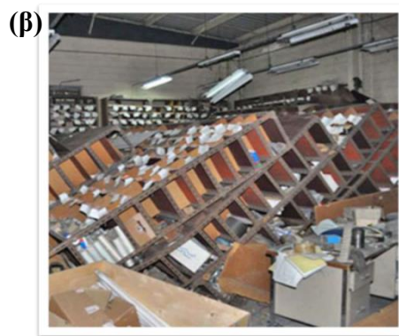
Εικόνα 2: α) Παραμόρφωση ορόφου \theta_i σε διώροφο κτήριο, β) εκτεταμένες ζημιές από επιτάχυνση ορόφου (από http://www.eucentre.it/non-structural-elements/?lang=en )
