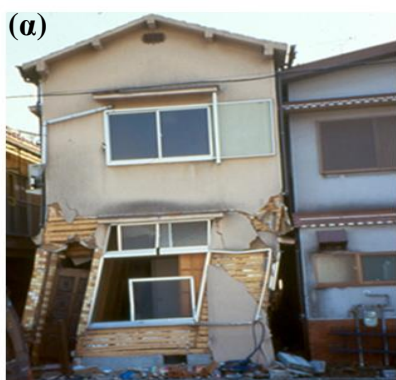
Εικόνα 2: α) Παραμόρφωση ορόφου \theta_i σε διώροφο κτήριο, β) εκτεταμένες ζημιές από επιτάχυνση ορόφου (από http://www.eucentre.it/non-structural-elements/?lang=en )
