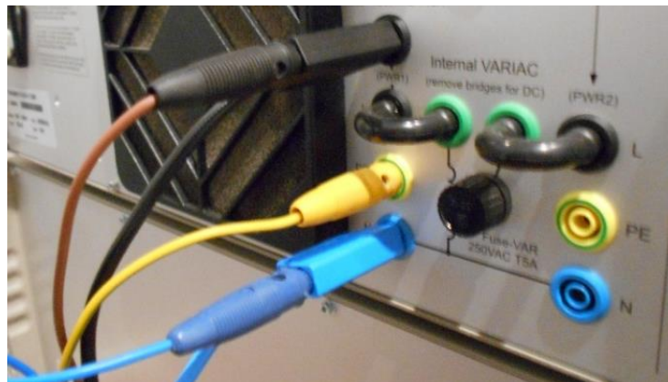
ΕΙΚΟΝΑ 4- 5 : ΣΥΝΔΕΣΗ ΑΚΡΟΔΕΚΤΩΝ ΚΑΛΩΔΙΟΥ ΤΡΟΦΟΔΟΣΙΑΣ, ΑΚΡΟΔΕΚΤΩΝ ΚΑΤΑΜΕΡΙΣΤΗ ΚΑΙ ΥΠΟΔΟΧΕΩΝ ΓΕΝΝΗΤΡΙΑΣ.
