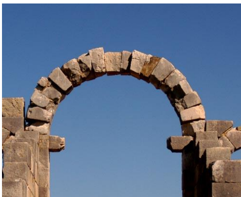
Σχήμα 2.4. Τόξο voussoir σε αψιδωτή κατασκευή.
