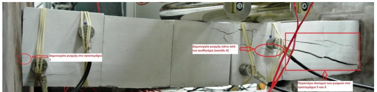
Σχήμα 7.47. Περαιτέρω άνοιγμα και επέκταση των ρωγμών στα ογκοτεμάχια 5 και 6, και δημιουργία νέων στα ογκοτεμάχια 1 και 4.
