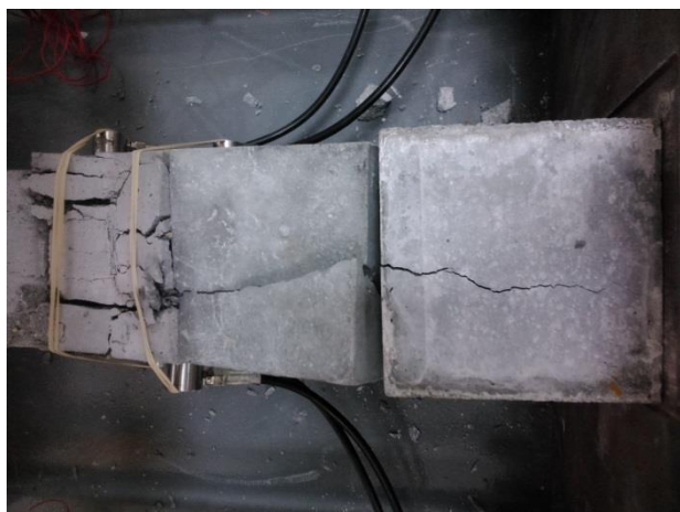
Σχήμα 7.73.Το πάνω μέρος της δοκού μετά την αστοχία.
