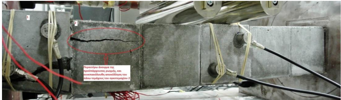
Σχήμα 7.55.Περαιτέρω άνοιγμα της προϋπάρχουσας ρωγμής και συνεπακόλουθη αποκόλληση του πάνω τεμάχους του ογκοτεμαχίου 2.
