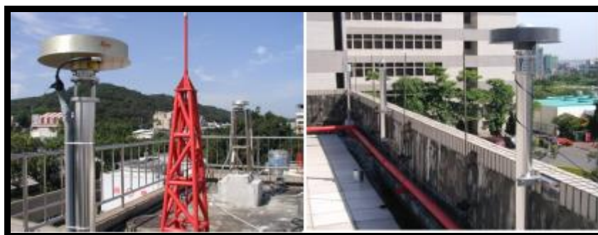
Εικόνα 3.1 Τοποθέτηση σταθερών δεκτών [Πηγή : dx.doi.org,2014]
