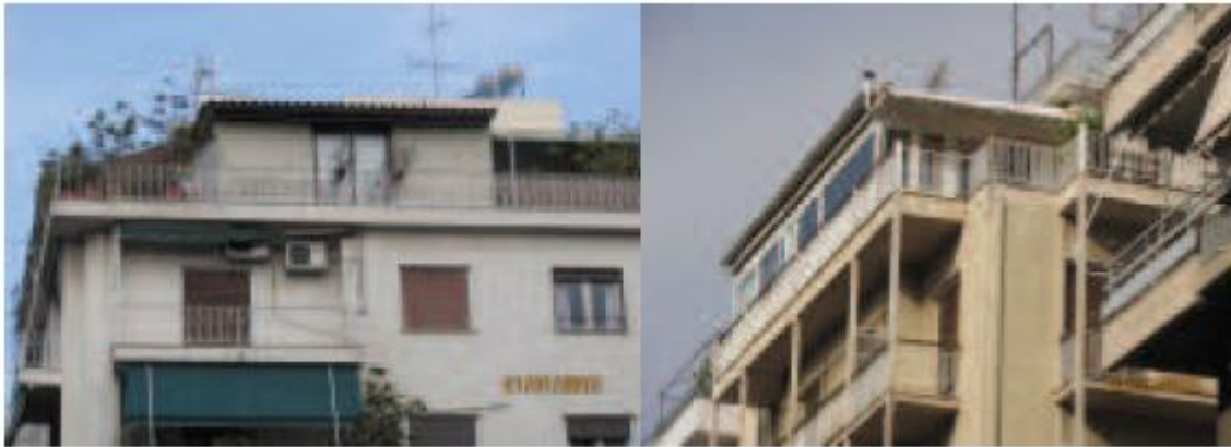
Εικόνα 2.6.1: Αυθαιρεσίες σε εντός σχεδίου περιοχές μέσα στα επικυρωμένα όρια του συνολικού όγκου του κτιρίου – Υπάγονται στον 4014/2011 85
