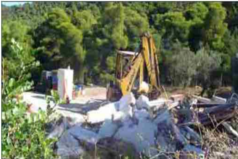
Εικόνα 2.1.1: Κατεδάφιση κτιρίων σε περιοχές ειδικού ενδιαφέροντος 63
