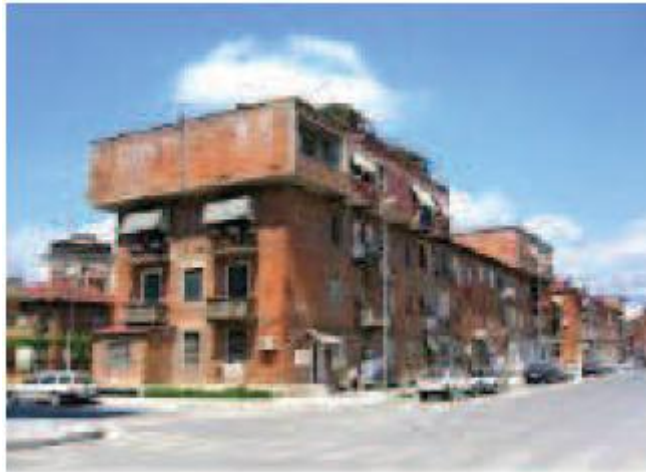
Εικόνα 1.4.2: Υπέρβαση Οικοδομικής Άδειας σε Υφιστάμενο Κτίριο 37
