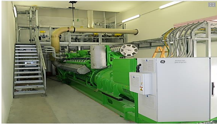
Εικόνα 75: Μονάδα συμπαραγωγής Pyrox
