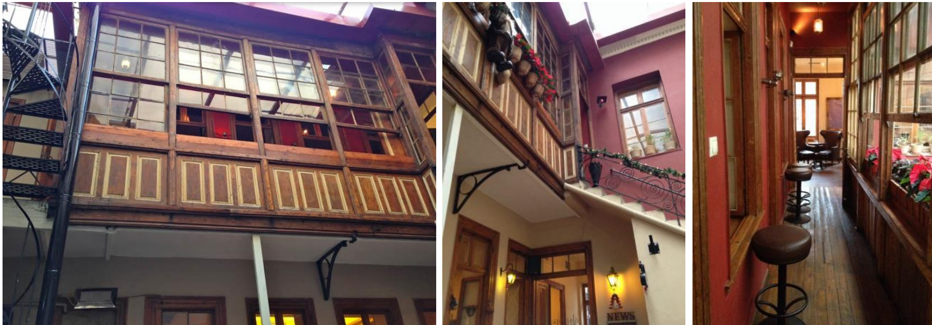
Εικόνα 17. Λιακωτό – θερμοκήπιο σε κτίριο στην περιοχή των Εξαρχείων
