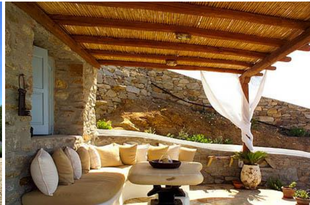
Εικόνα 19. Στέγαστρο από καλαμωτή
