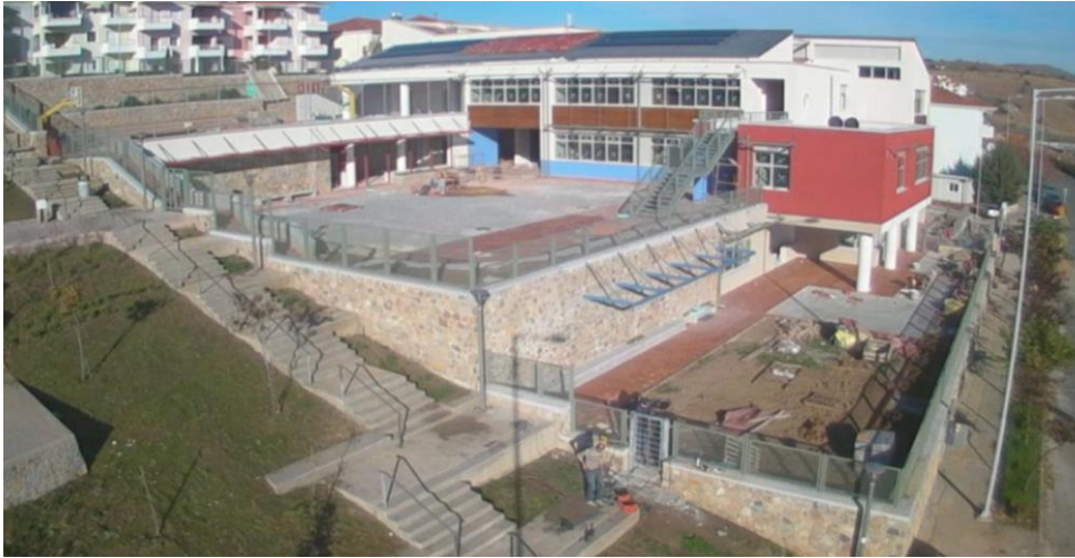
Εικόνα 53. Νοτιοανατολική όψη σχολείου στην Κοζάνη
