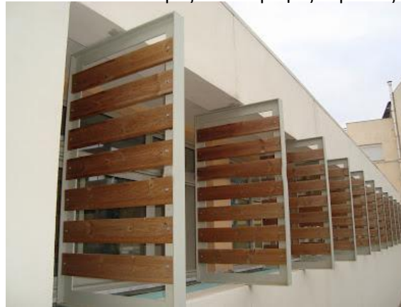
Εικόνα 51. Σταθερές κατακόρυφες περσίδες
