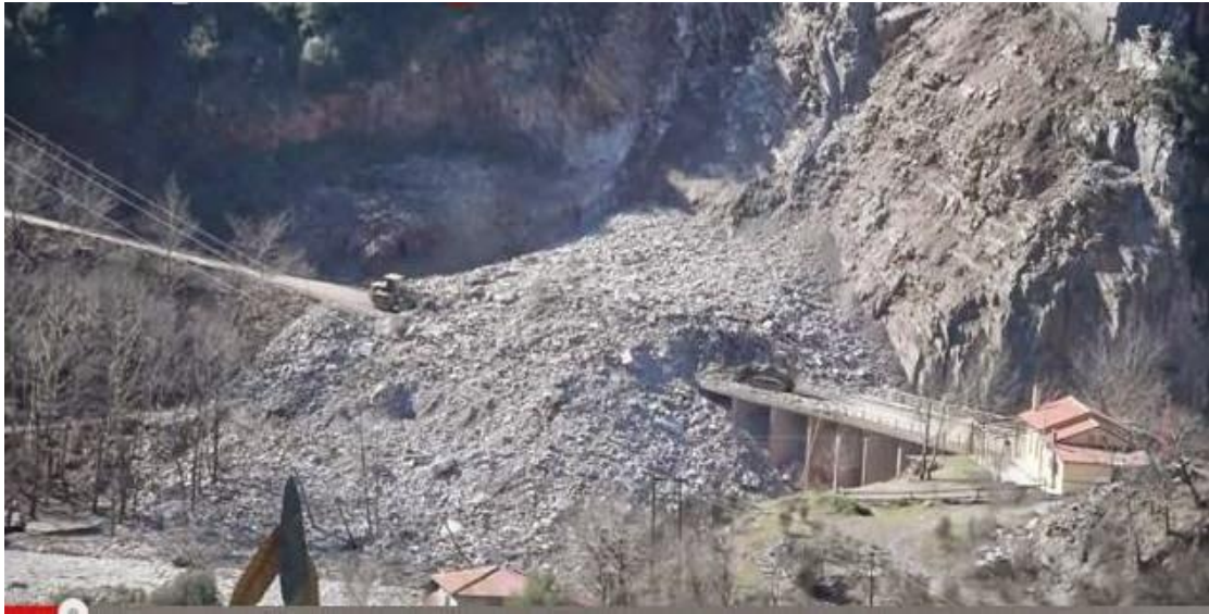
Εικόνα 2. 19: Κατολίσθηση στη θέση Διπόταμα κοντά στο χωριό Προυσό του νομού Ευρυτανίας που εκδηλώθηκε στις 19/2/2015.
