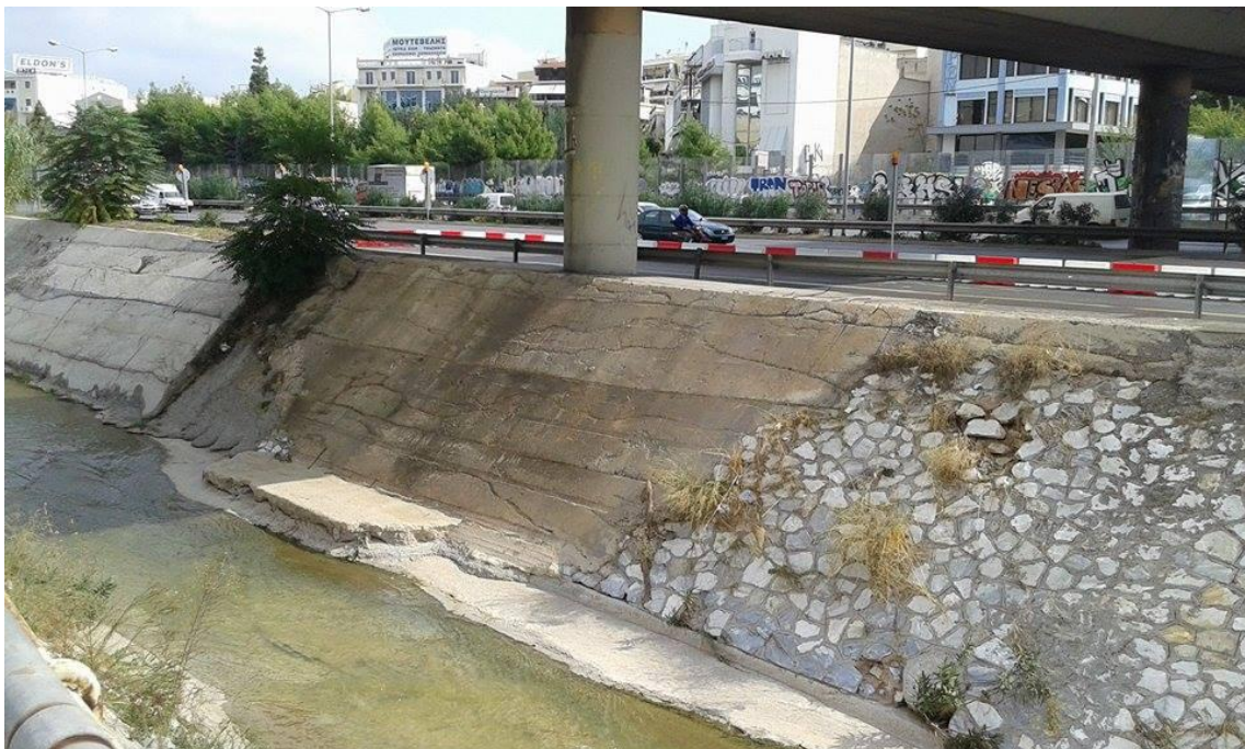
Εικόνα 2.4: Τοπικές αποκαταστάσεις πρηνών με έγχυτο σκυρόδεμα.
