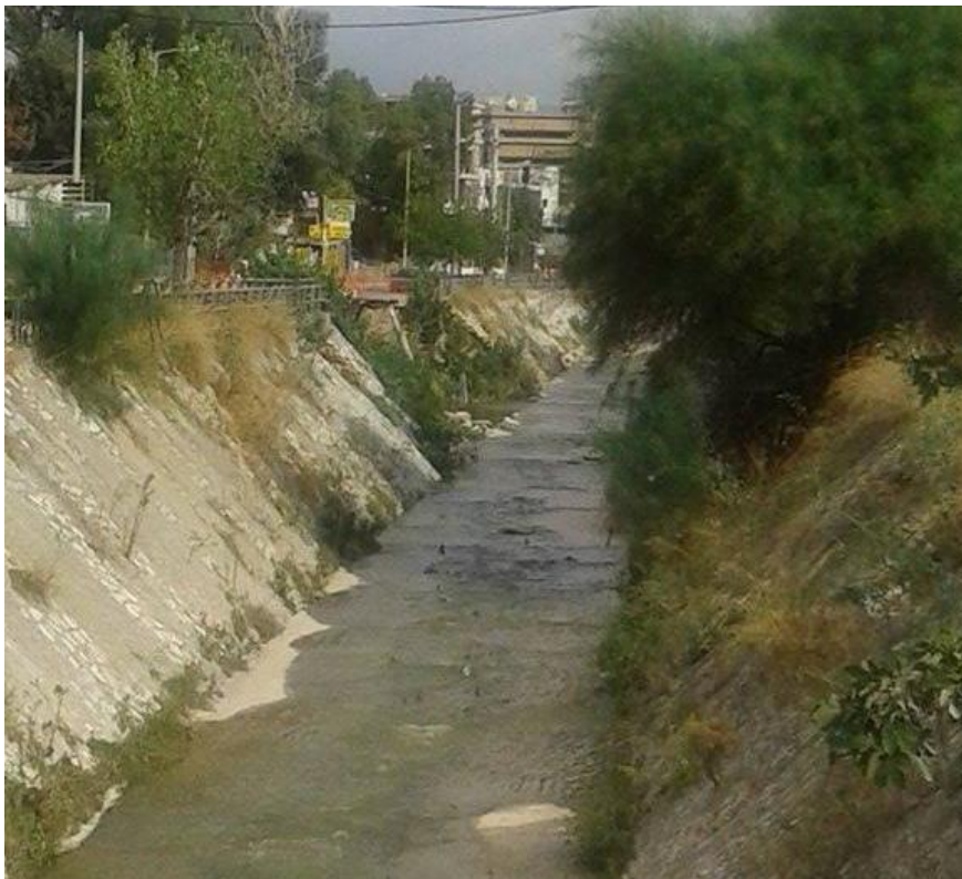
Εικόνα 3.2: Ανατολικό πρηνές επενδυμένο με λίθους έως ένα συγκεκριμένο ύψος.
