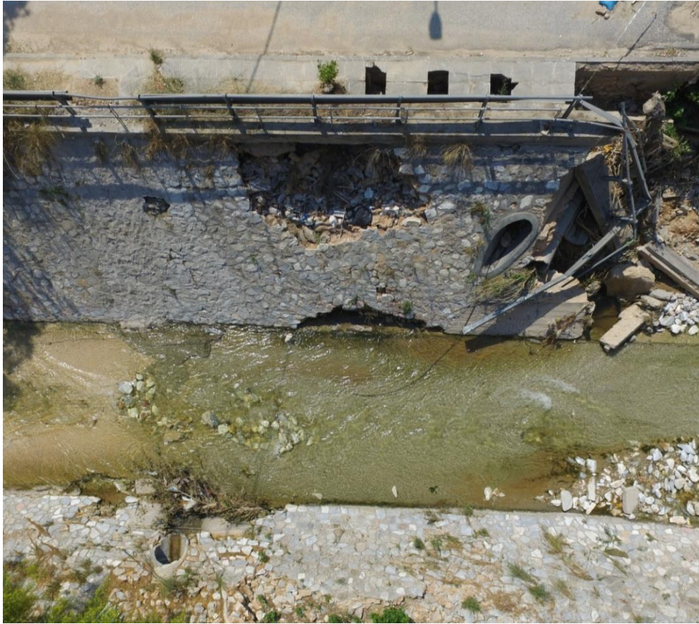
Εικόνα 2.6: Δημιουργία εγκοίλου και αποκόλληση λιθένδυτης επένδυσης.
