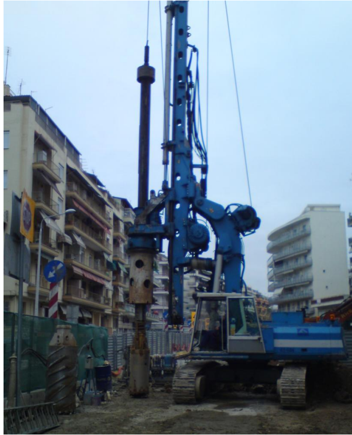
Εικόνα 4.41: Διάνοιξη οπών με διατρητικό μηχάνημα.
