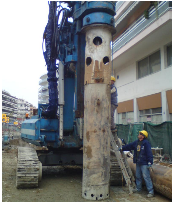
Εικόνα 4.42: Διάτρηση οπής με χρήση μεταλλικού σωλήνα προστασίας πλευρικών τοιχωμάτων.
