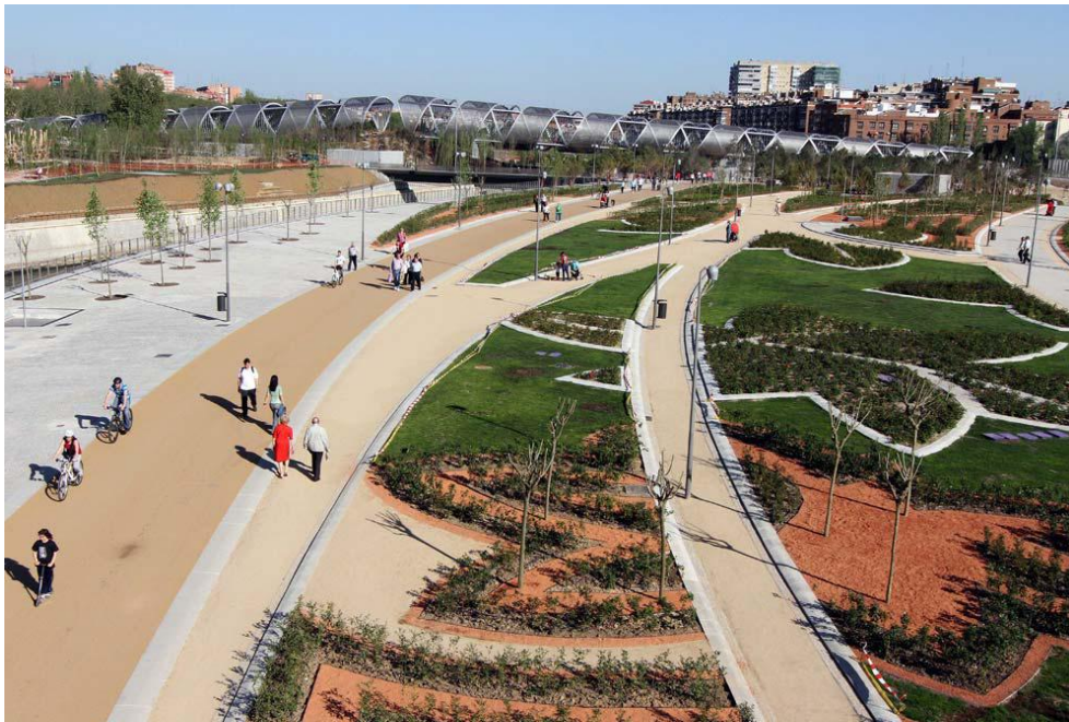
Εικόνα 1.6: Επιφανειακή ανάπλαση αυτοκινητόδρομου Madrid Calle 30 στη Μαδρίτη.
