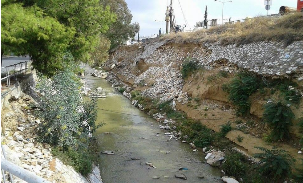
Εικόνα 3.1: Ανατολικό πρηνές επενδυμένο με λίθους καθ' όλο το ύψος του.
