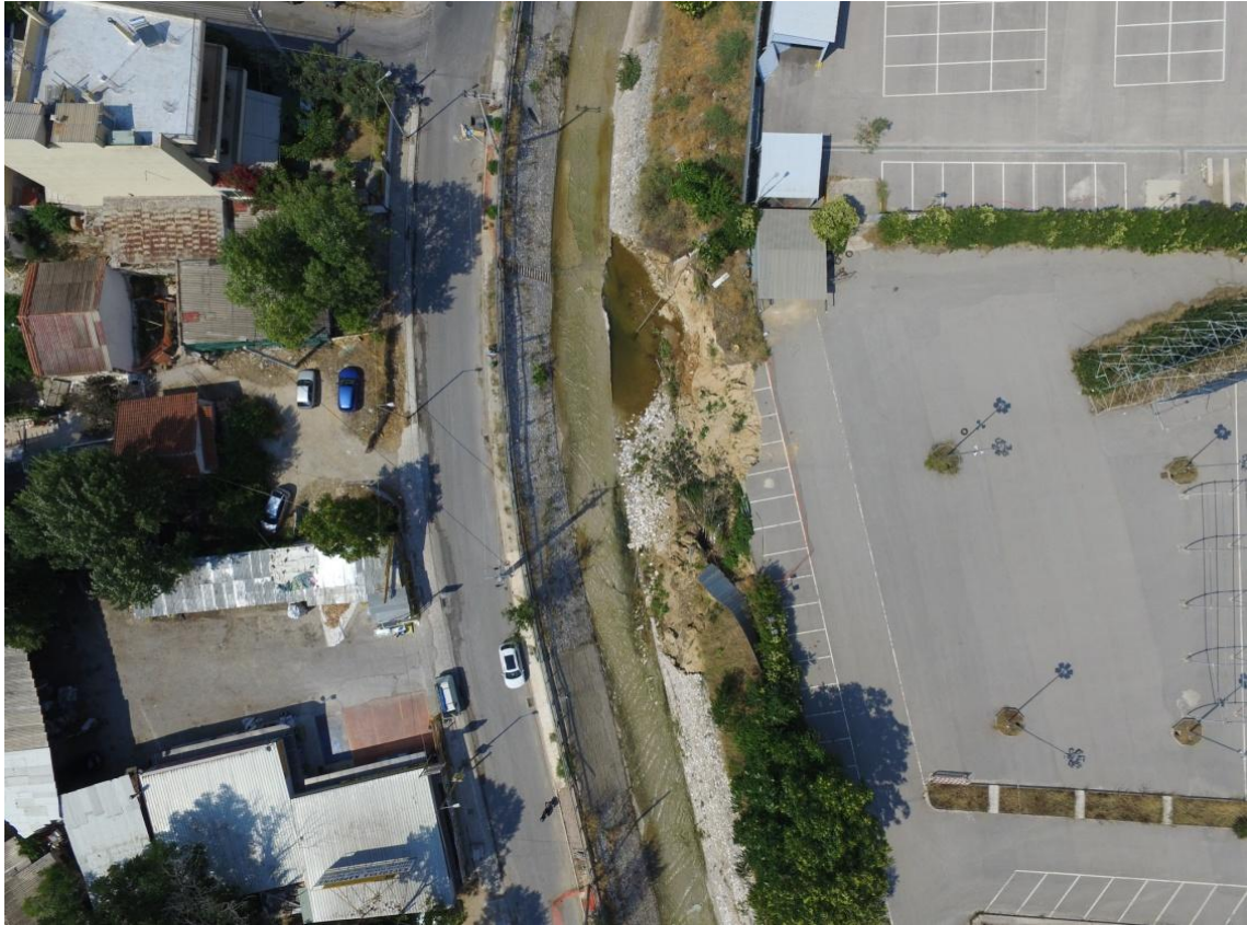
Εικόνα 2.9: Πανοραμική άποψη της καταστροφής του ανατολικού πρσανούς στο εσωτερικό της αλλαγής διεύθυνσης.
