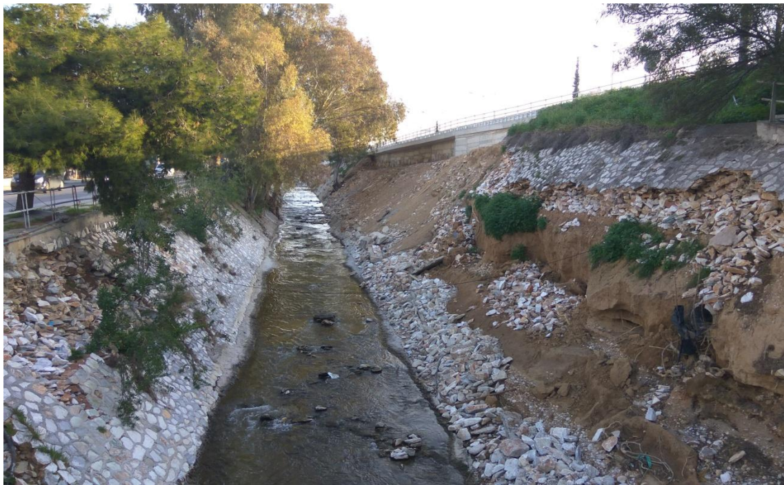
Εικόνα 2.12: Ολοκλήρωση της εφαρμογής φρεατοπασσάλων για ενίσχυση του ανατολικού πρανούς στη συμβολή της εξόδου ΠΑΘΕ προς τη Λ. Κατσώνη.
