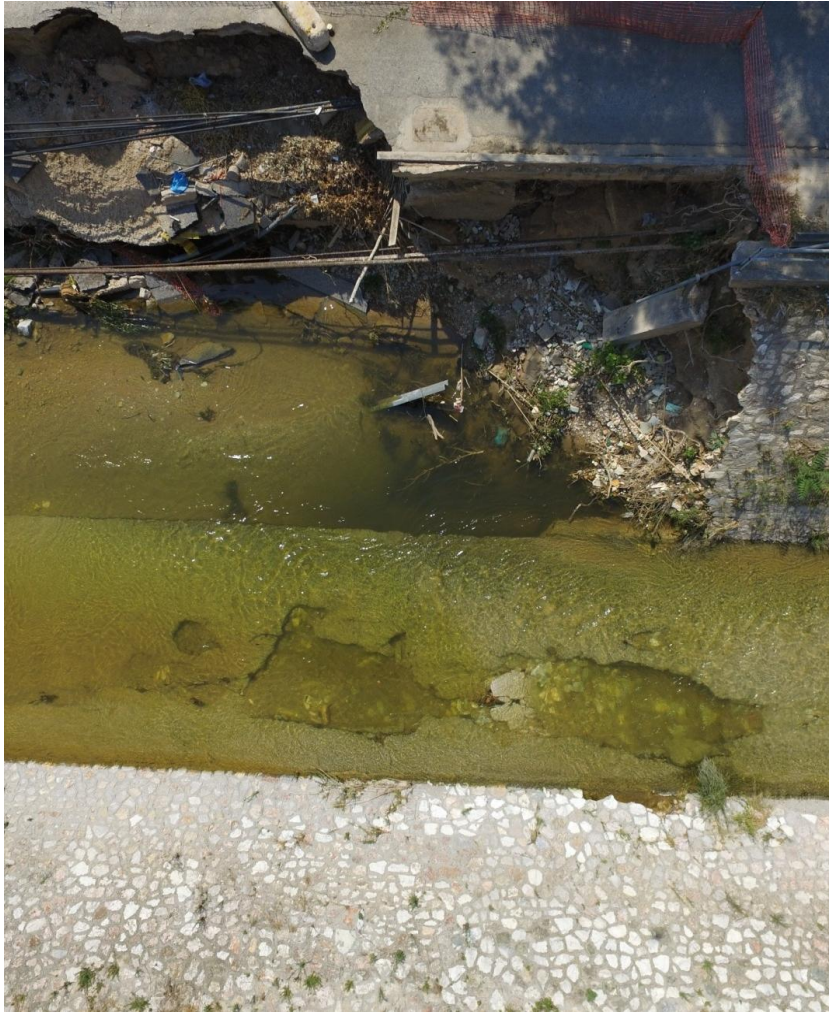
Εικόνα 2.5: Μετατόπιση εδαφικού υλικού και τελικά θραύση της υπερκείμενης κοιτόστρωσης.
