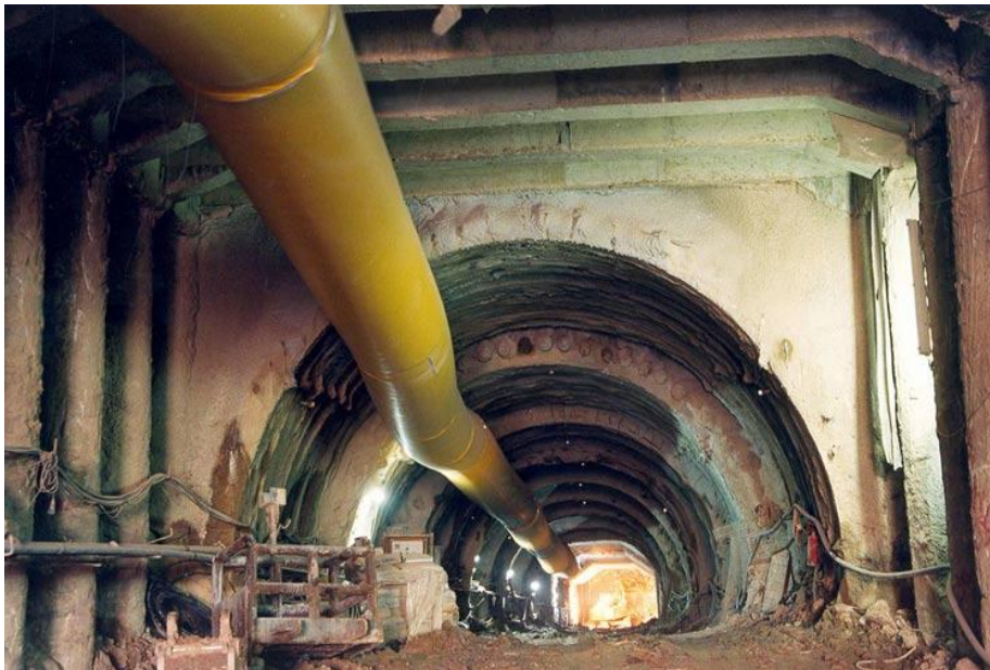
Εικόνα 1.12 α & β: Κατασκευή σήραγγας εκτροπής Ποδονίφτη.
