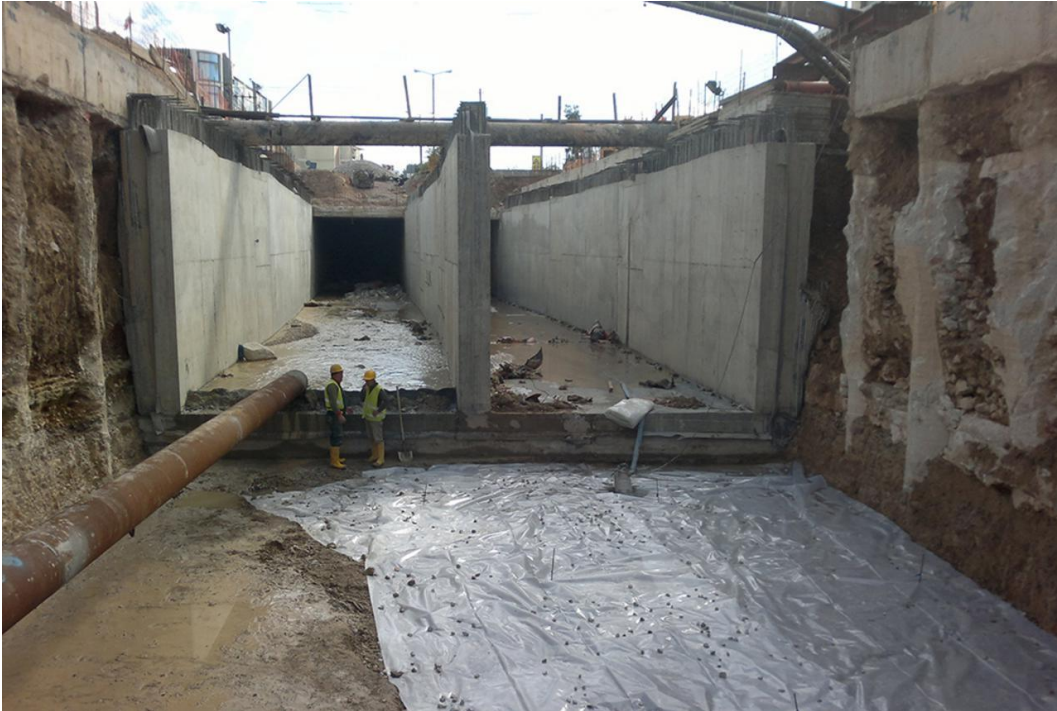
Εικόνα 1.9: Κατασκευή δίδυμο κλειστού ορθογωνικού οχετού στο Ρέμα Εσχατιάς.
