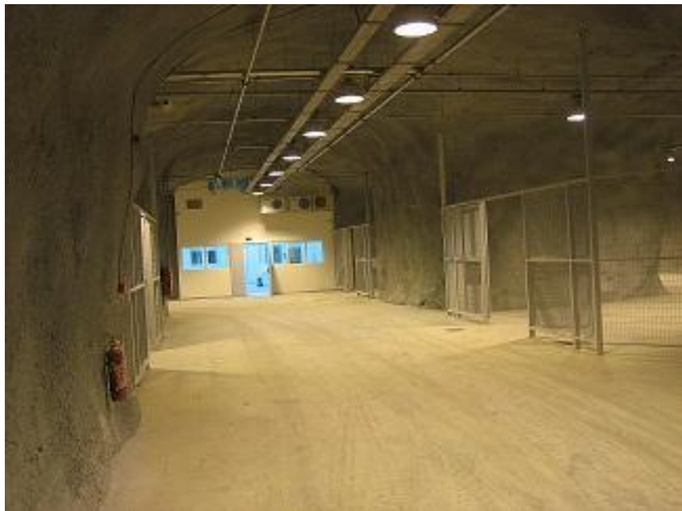
Εικόνα 1.4: Υπόγειος χώρος Αποθήκευσης Επικίνδυνων Αποβλήτων στο Λαύριο.
