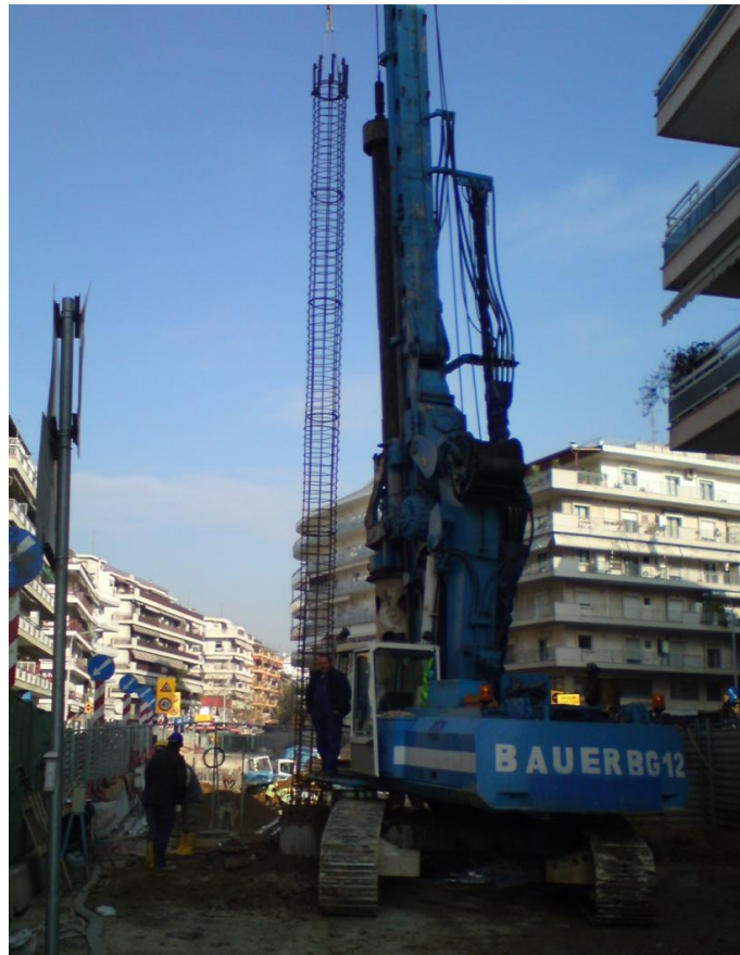
Εικόνα 4.43: Τοποθέτηση κλωβού οπλισμού εντός της οπής.
